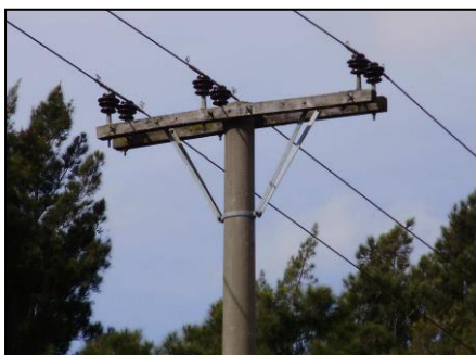
Postes de hormigón
