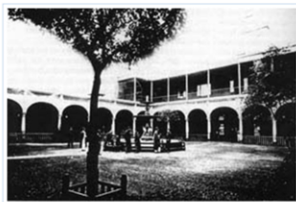
Pabellones del Hospital de Santa Ana
