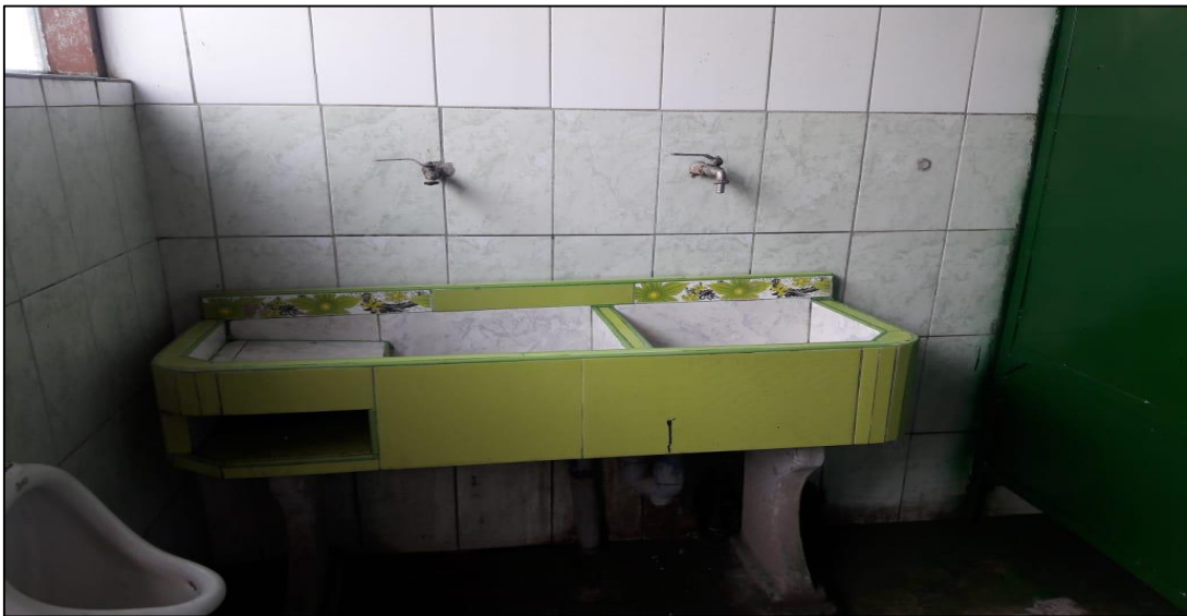
Figura 6: Servicios Higiénicos de la Planta de Operaciones de T.E. Prisma S.A.C.
