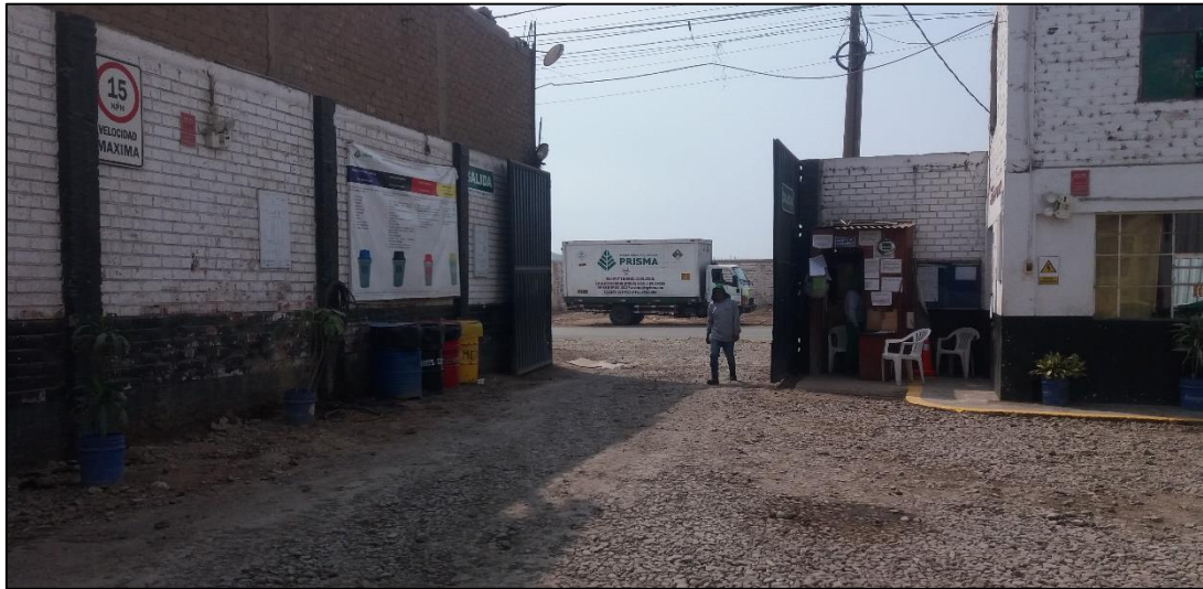
Figura 17: Vista interna hacia afuera la Planta de Operaciones de T.E. Prisma S.A.C.
