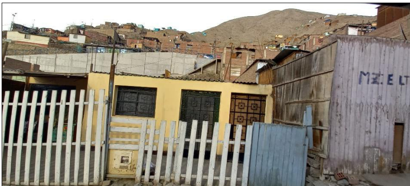
Fotografía 30. Vivienda autoconstruida de ladrillo con techo de calamina, alrededor viviendas precarias de madera.
