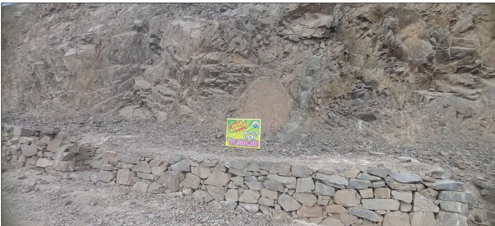
Fotografía 14. Presencia de letreros en los cuales se vende terrenos en zonas propensas a derrumbe.
