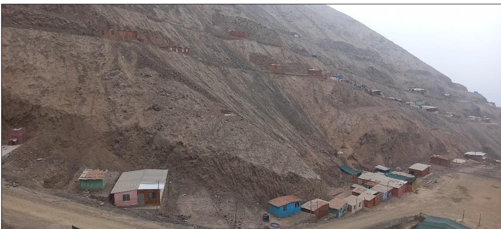
Fotografía 15. Viviendas propensas a deslizamiento de tierras.
