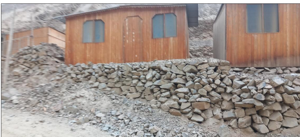
Fotografía 09. Viviendas precarias sobre pircado.
