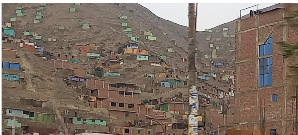
Fotografía 02. Viviendas de material noble y de madera en ladera de alta pendiente.
