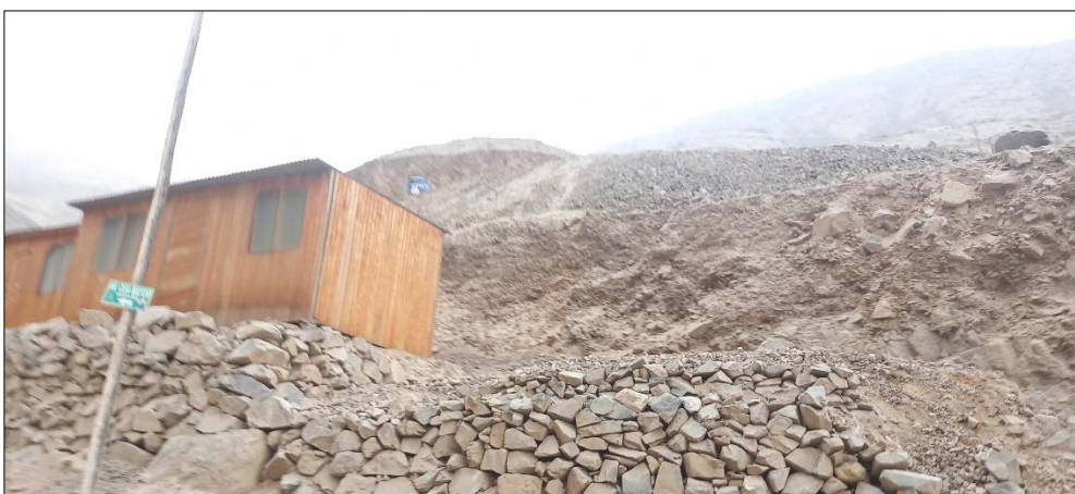
Fotografía 08. Viviendas de madera debajo de ladera en pendiente moderada, con presencia de material suelto.
