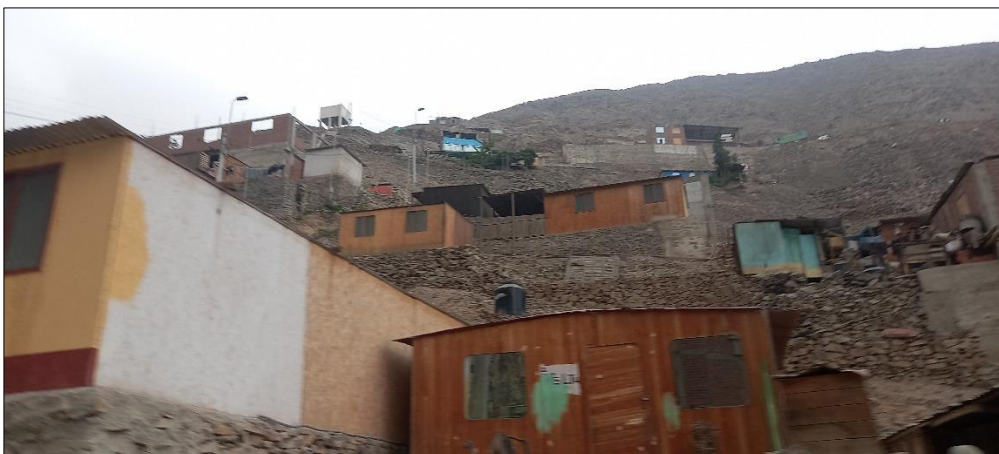
Fotografía 07. Viviendas de madera sobre pircado mezclado con concreto.
