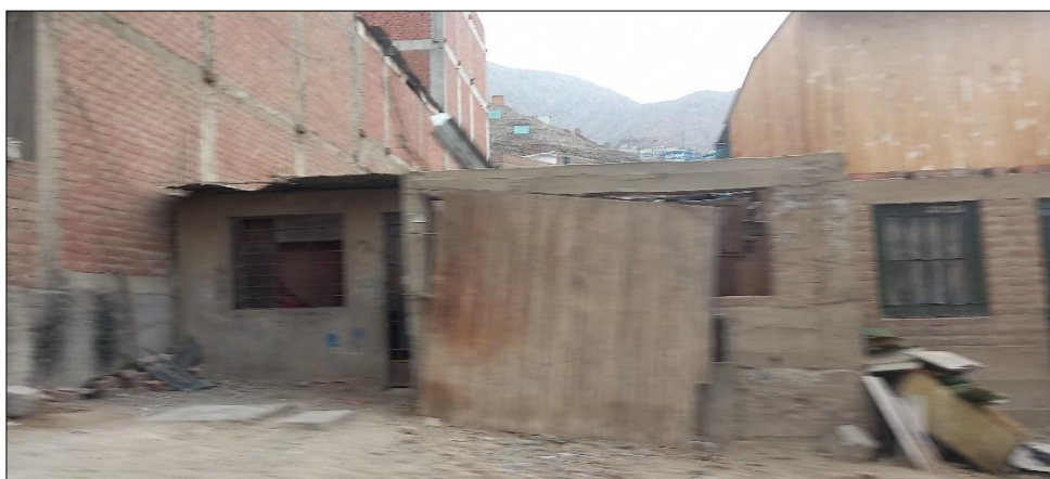
Fotografía 03 Vivienda de ladrillo autoconstruida con techo de calamina.
