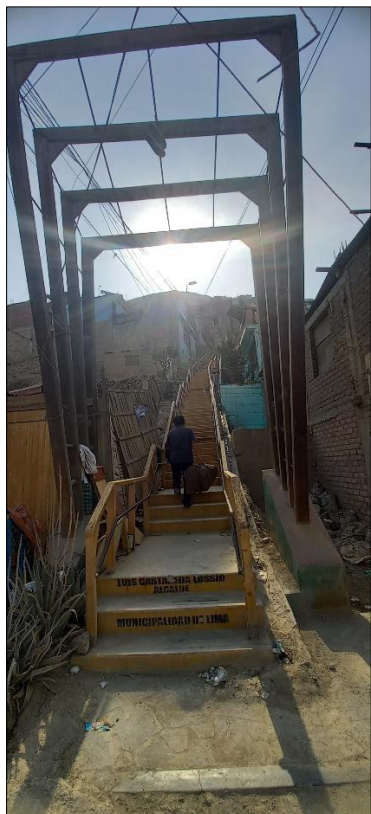
Fotografía 22. Escalera de concreto con barandas de madera, la cual conduce hacia las zonas altas.
