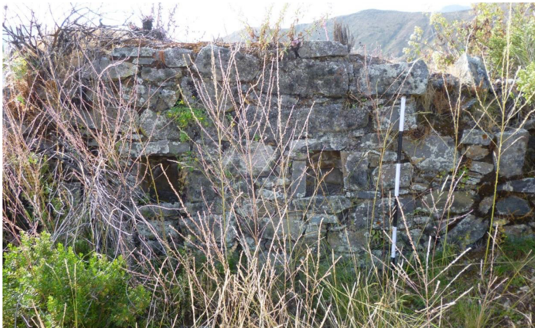
Edificio T-004 con vanos trapezoidales en Tunshuhuilca
