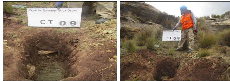
Calicata CT-09 - Km 15+600
