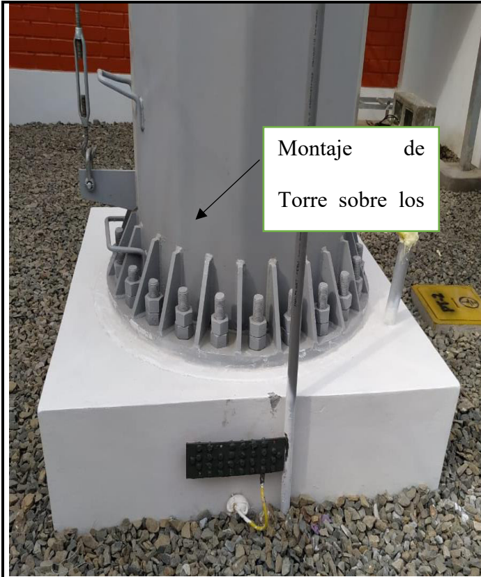
Descripción: Instalación de monopolo sobre cimiento
