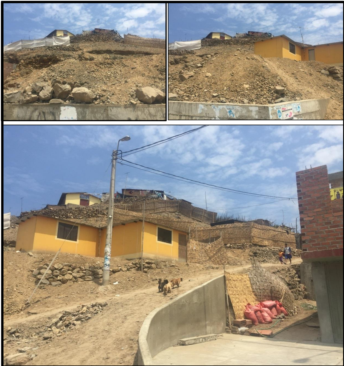
Figura N° 2: Fotografías de viviendas del centro poblado Pampa Libre que se encuentran sobre suelo de formaciones residuales con pendiente altas. (Fuente: Propia)
