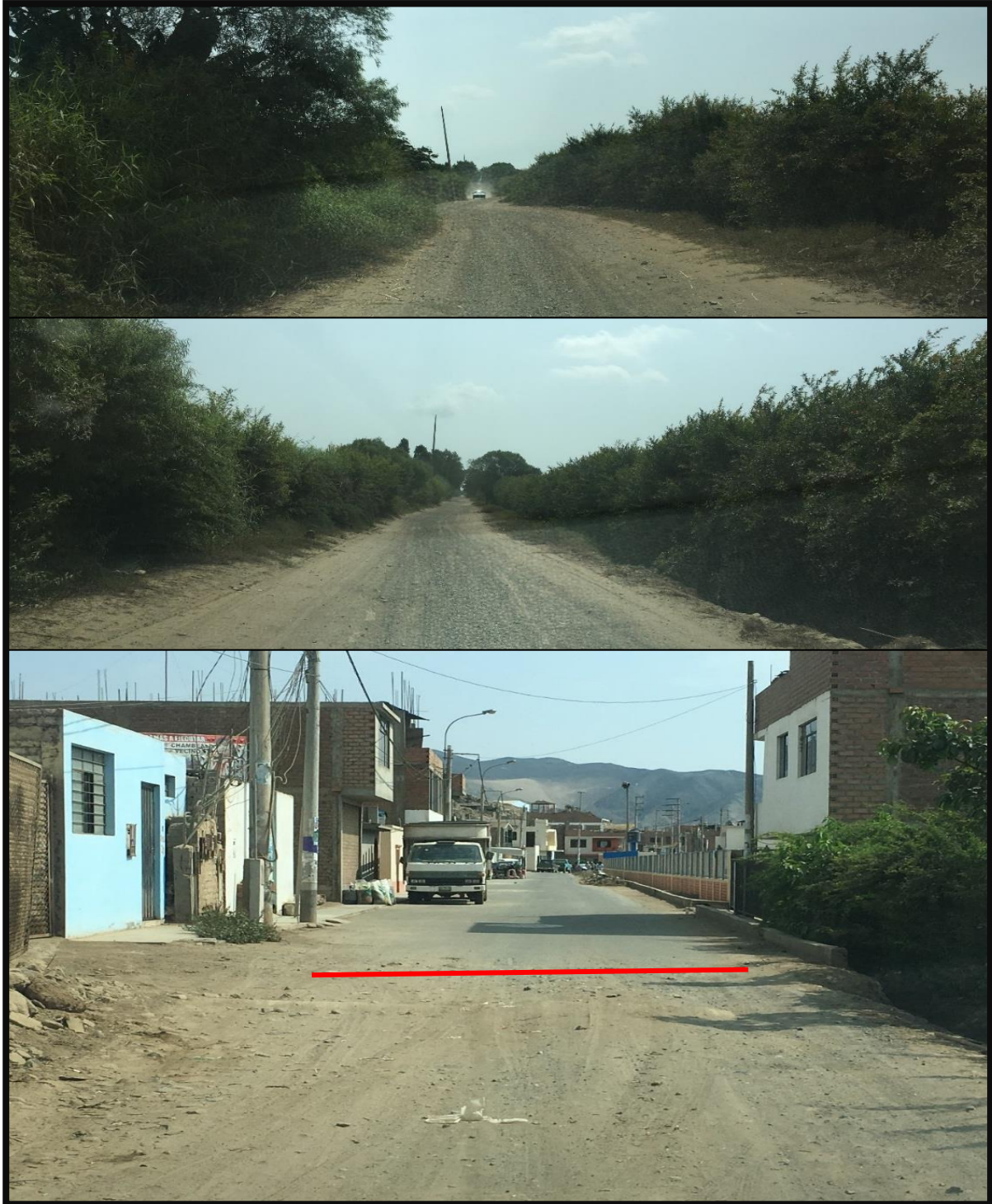
Figura N° 16: Fotografías de la vía afirmada que une al centro poblado de Palpa con la de Caqui, en la última imagen se ve el ingreso al centro poblado urbano Caqui y el cambio en la superficie de la vía de afirmada a asfaltada. (Fuente: Propia)
