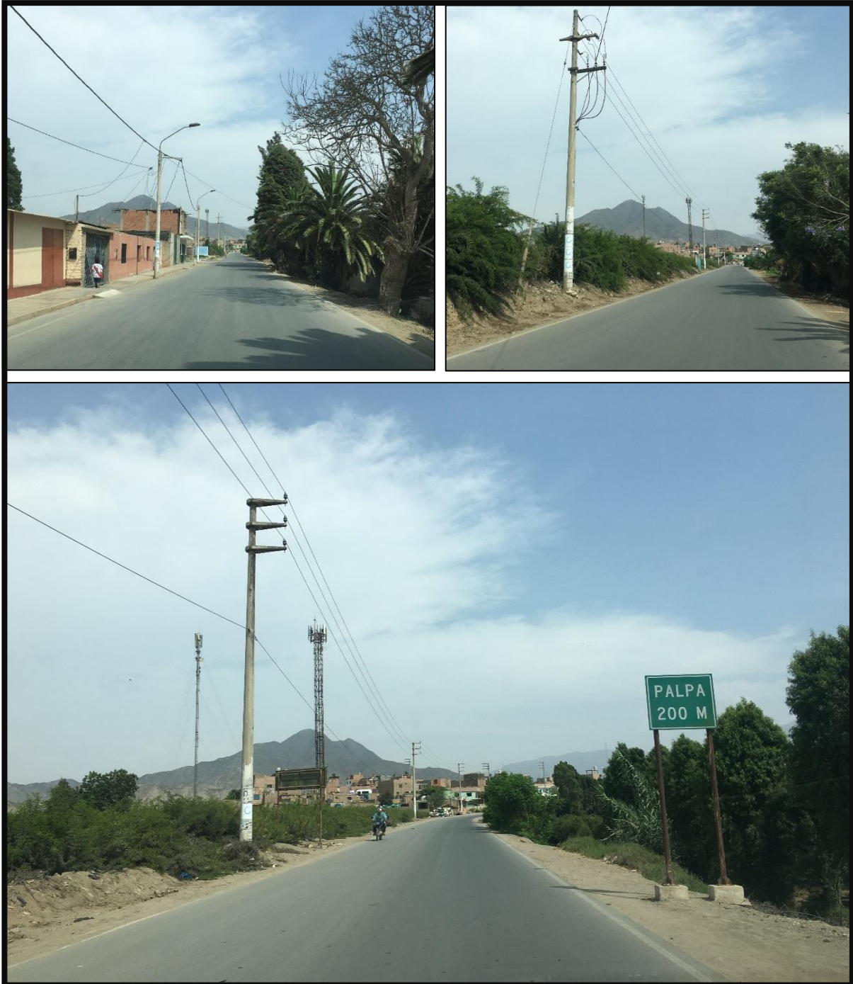
Figura N° 15: Fotografías de la entrada al centro poblado urbano Palpa donde se observa el asentamiento de viviendas colindantes a la vía asfaltada y a la red de distribución eléctrica. (Fuente: Propia)
