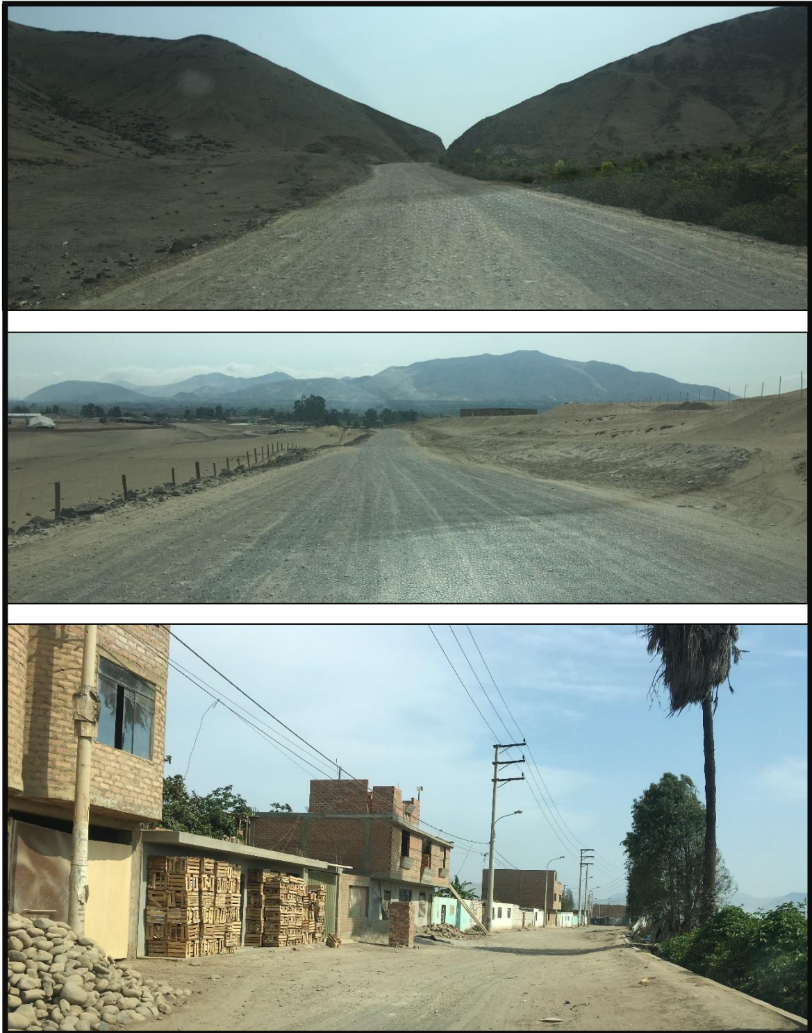
Figura N° 20: Fotografías carretera que une tres estrellas con Miraflores, vía solo afirmada sin red de electrificación en su trayectoria, dentro del centro se encontró la red de distribución eléctrica pero no servicios de agua potable ni saneamiento. (Fuente: Propia)
