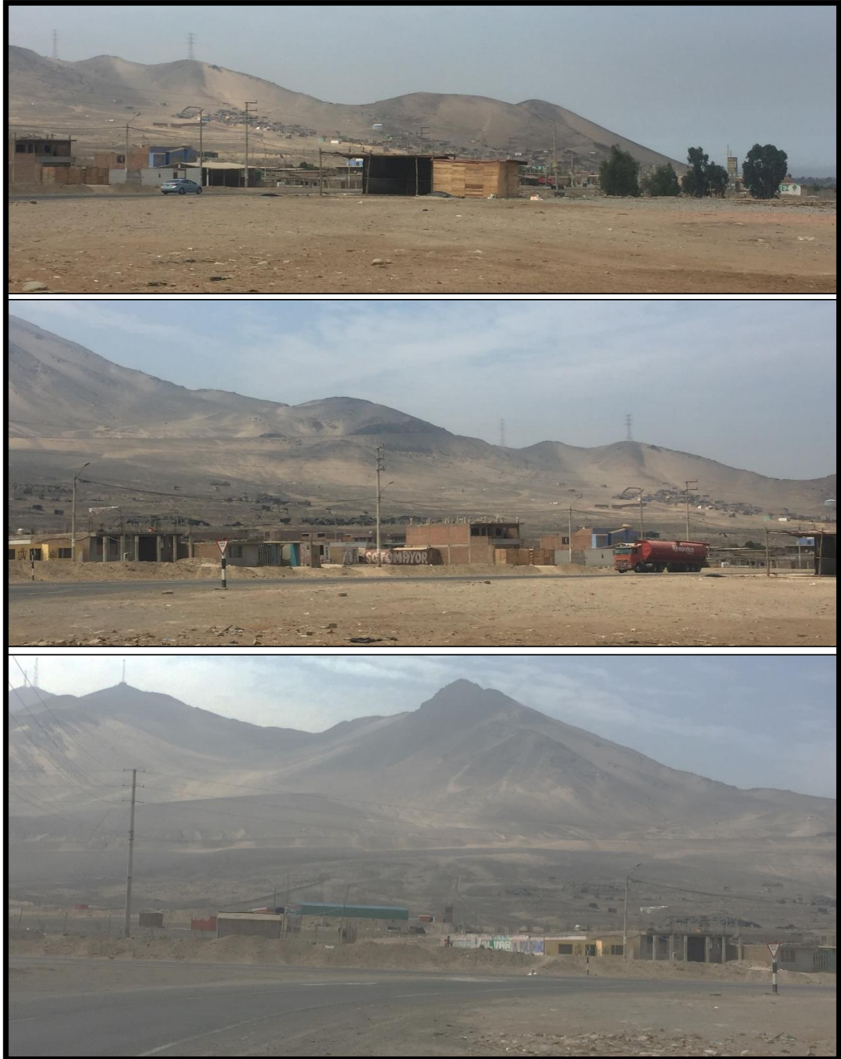
Figura N° 6: Fotografías del centro poblado Salinitas que se encuentra colindante a la carretera de la Panamericana Norte a la altura del kilómetro 72.5 situada sobre suelos de origen eólico y muy cerca de una falla geológica. (Fuente: Propia)
