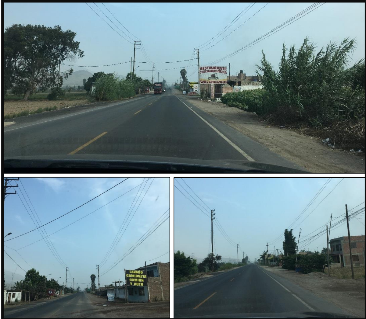
Figura N° 10: Fotografías de la carretera que se dirige hacia la ciudad de Huaral desde la panamericana norte, donde el asentamiento de viviendas hace más latente por la actividad económica, accesibilidad (vías asfaltadas) y electrificación. (Fuente: Propia)
