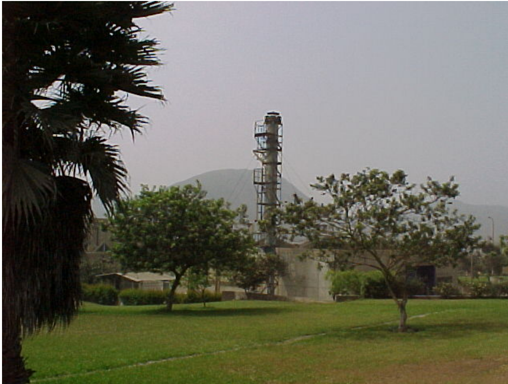
Figura N° 1. Chimenea de la PPR
