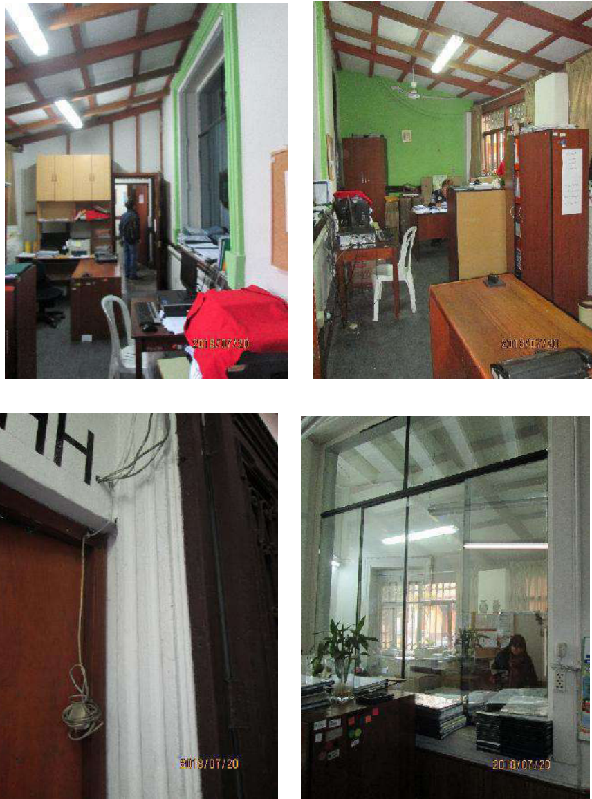
Ilustración 13: Imágenes que ejemplifican condición de componentes y criterios de Seguridad Fuente: Archivo fotográfico del Estudio
