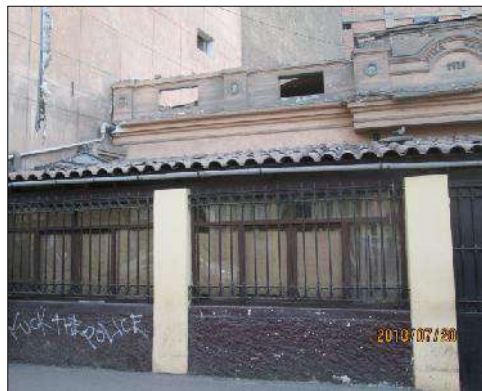
Ilustración 15: Fachada de edificación principal. Anexo frontal de material noble (muros de albañilería) y cobertura ligera (tijeira de madera)
