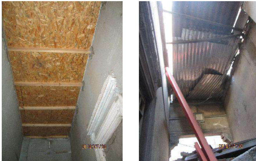
Ilustración 6: Vista de techado de patio de servicio Fuente: Archivo fotográfico del Estudio
