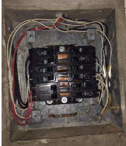
Ilustración 25: Interruptores termomagnéticos Fuente: Archivo fotográfico del estudio
