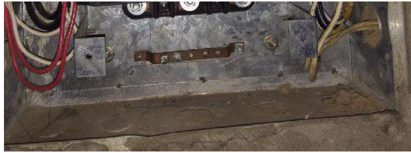
Ilustración 28: Barra de Cu, tierra Fuente: Archivo fotográfico del estudio
