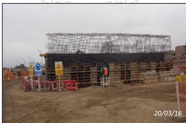
Fotografía N° 06: Armado de estructuras
