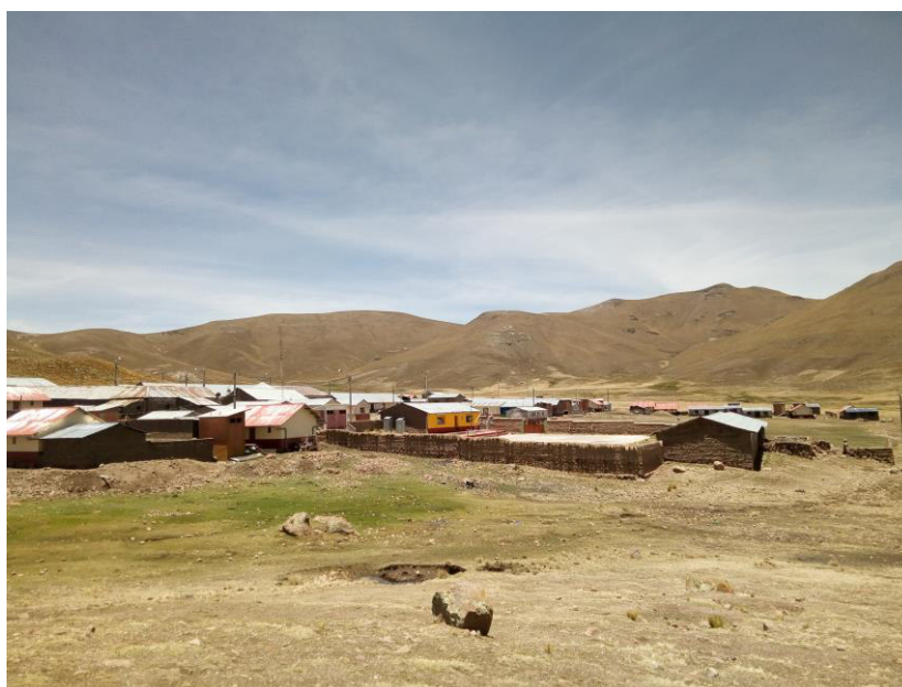
Foto N° 16.- Vista Panorámica de la Comunidad de Toroya, donde se observa las UBS del Tipo Compostera que han sido construidos.
