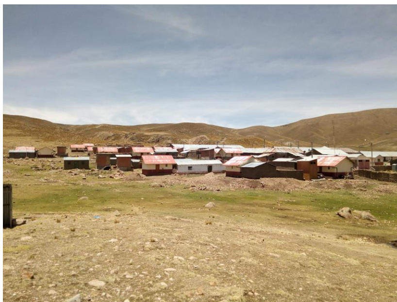
Foto N° 15.- Vista Panorámica de la Comunidad de Toroya, donde se observa las UBS del Tipo Compostera que han sido construidos.
