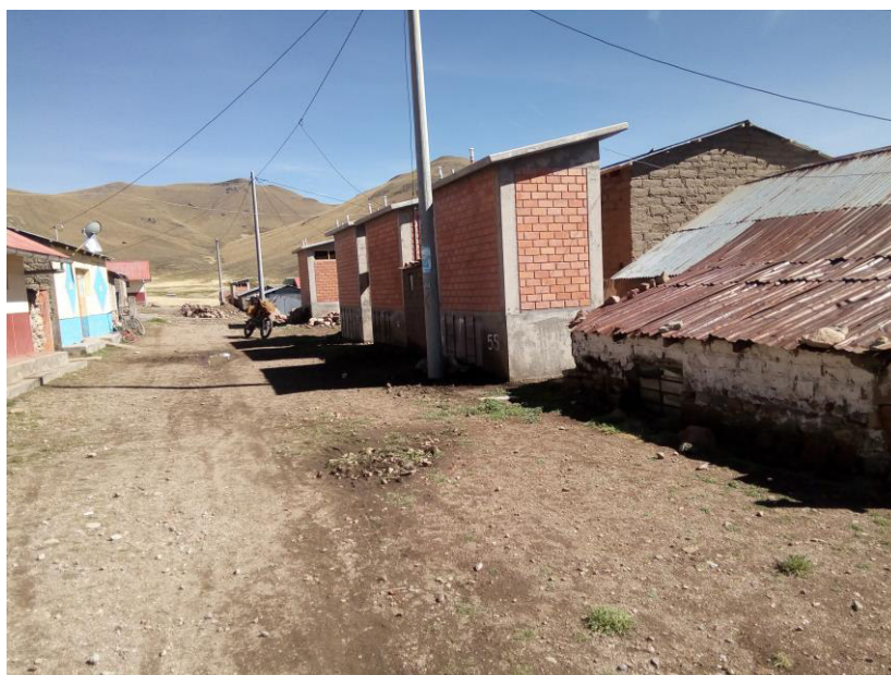
Foto N° 12.- Vista panorámica de las UBS del tipo compostera ejecutadas en la Comunidad de Toroya.
