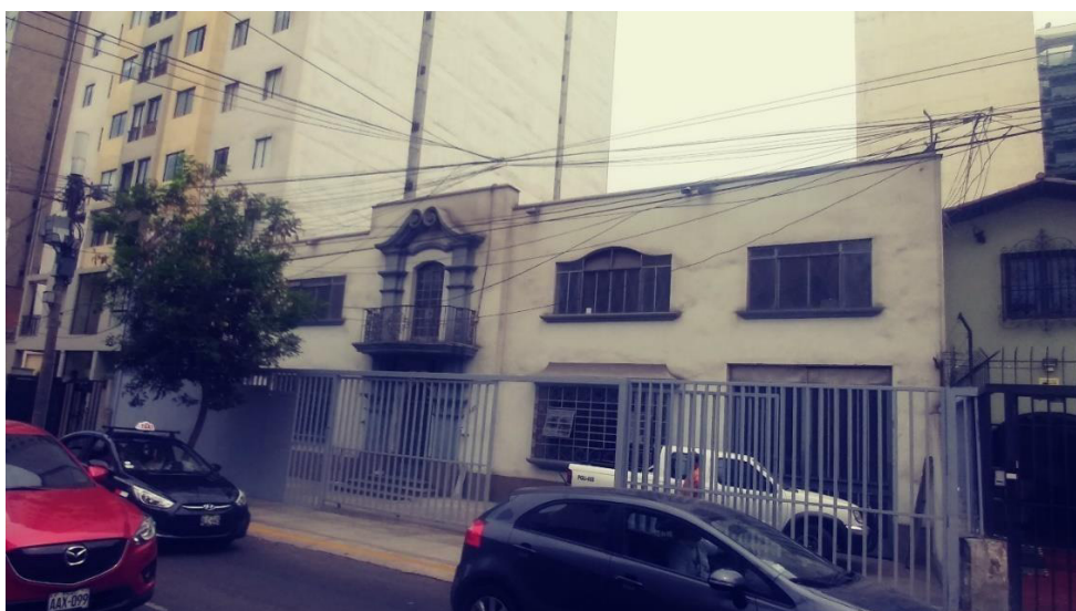
Figura 7. Fotografía del terreno, con la edificación antes de demoler
