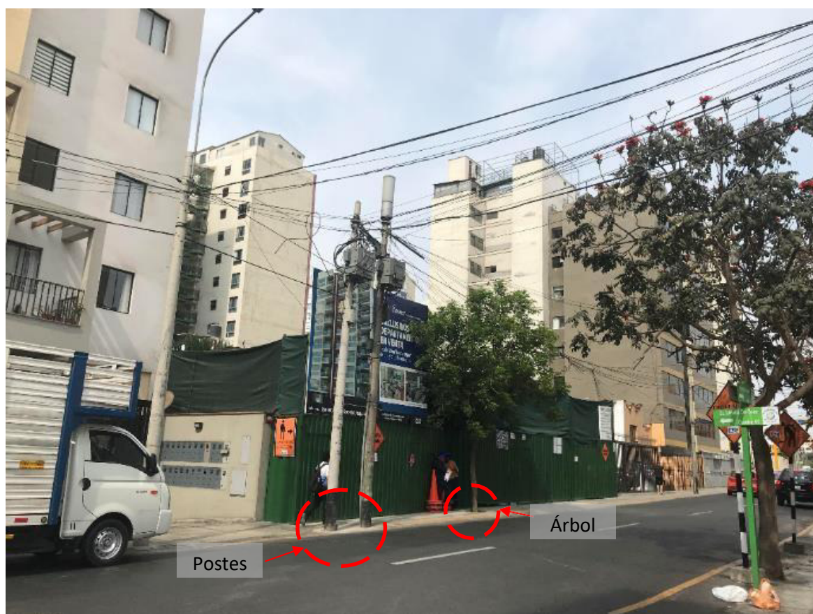
Figura 8. Fotografía del terreno terminada la demolición
