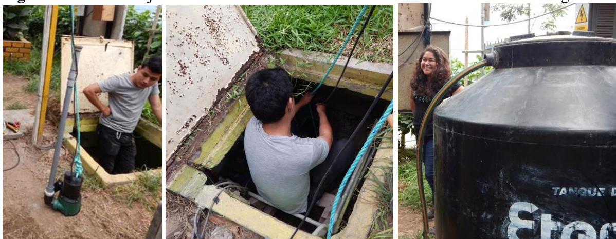
Figura 3.2.1.3.i. Conjunto de vistas durante la instalación de la electrobomba sumergible.
