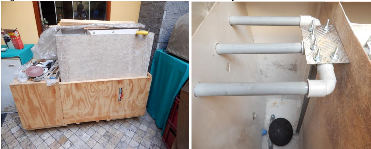
Figura 3.2.1.1.d. Dos Vistas del Reactor durante el montaje.
