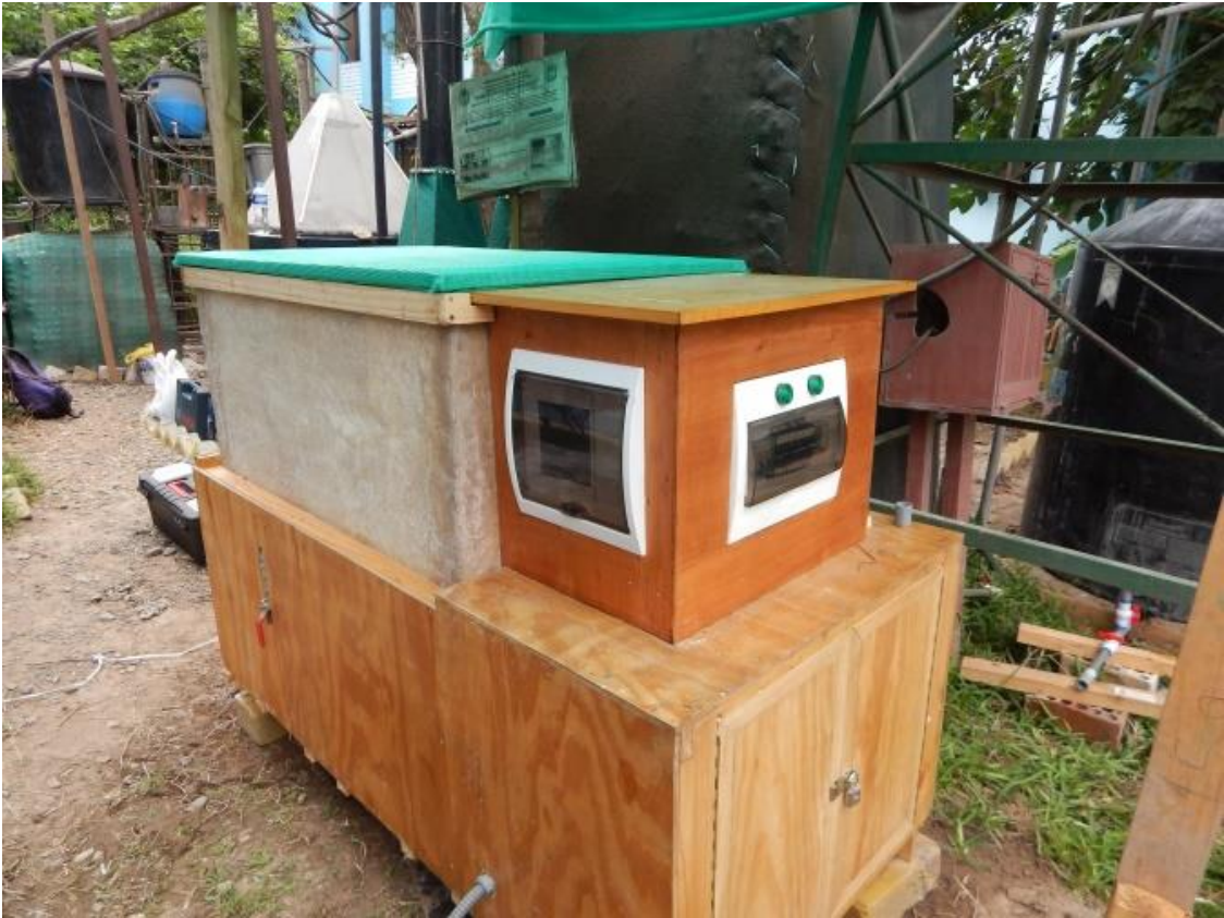
Figura 3.2.1.3.j. Vistas del Sistema de Tratamiento Compacto de Lodos Activados del Tipo Secuencial.
