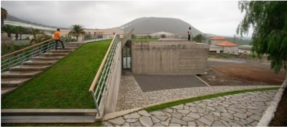
Figura 10: Vista lateral de la Casa de la Juventud de los Silos
