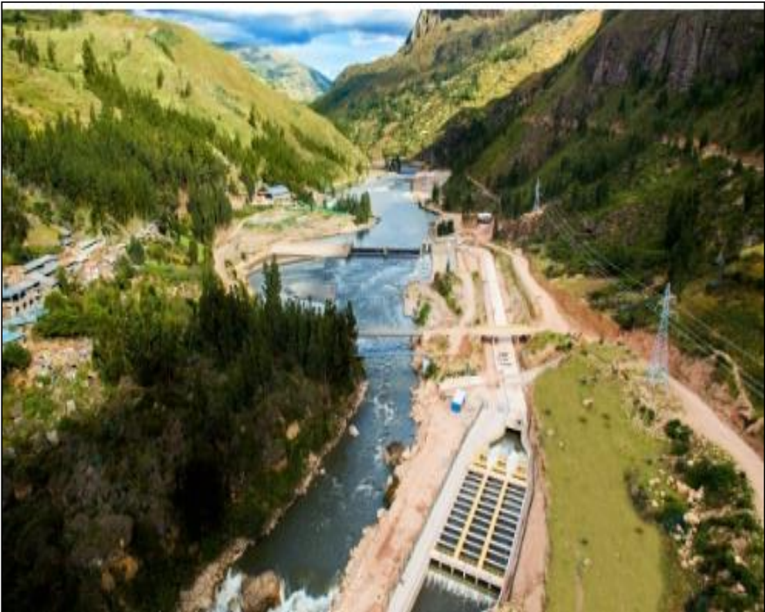
Figura 76: Vista panorámica de la central Hidroeléctrica Marañón
