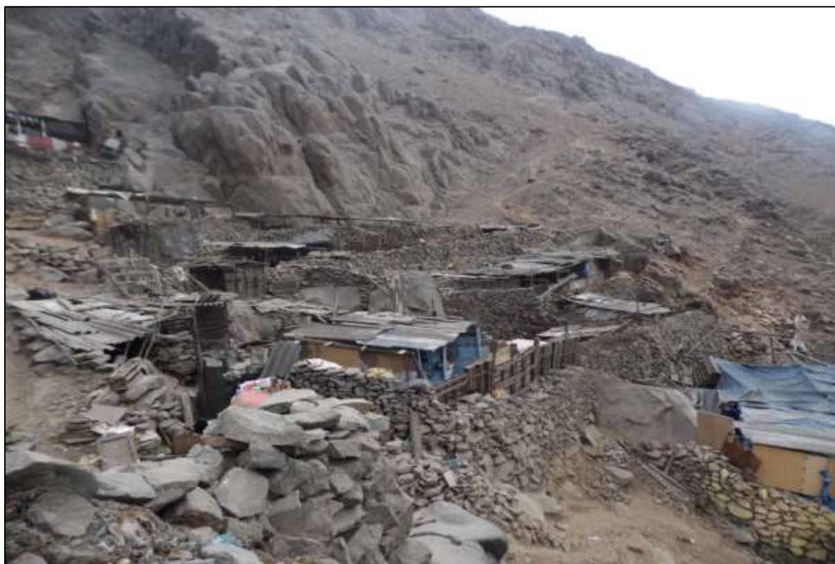
Foto 8. Asentamientos informales en las Lomas El Mirador
