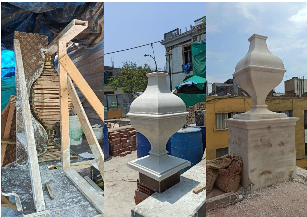
Fig. 09: Fases del monitoreo: Proceso constructivo de ánfora de quinchá revestida con trabadillo.
