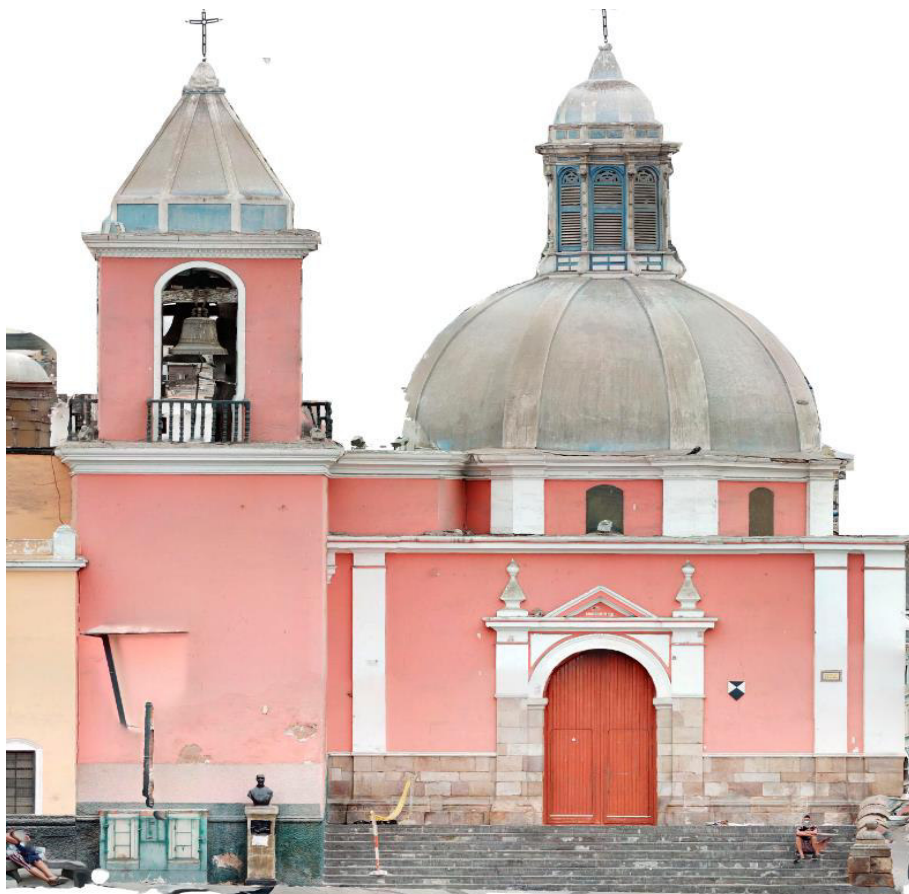
Fig. 04: Ortofoto de la fachada principal. Templo de la Buena Muerte
