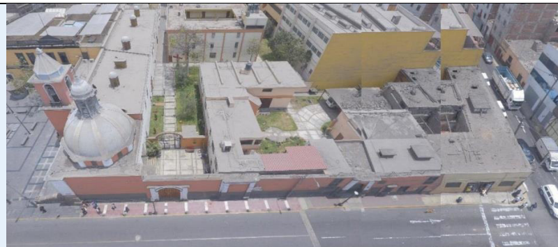
1.2. Fotografía del estado actual. Vista del Jr. Ancash y la Iglesia de la Buena Muerte.
