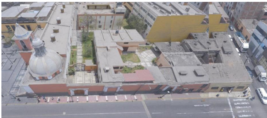
Fig. 02: Fotografía del estado actual. Vista del Jr. Ancash y la Iglesia de la Buena Muerte.
