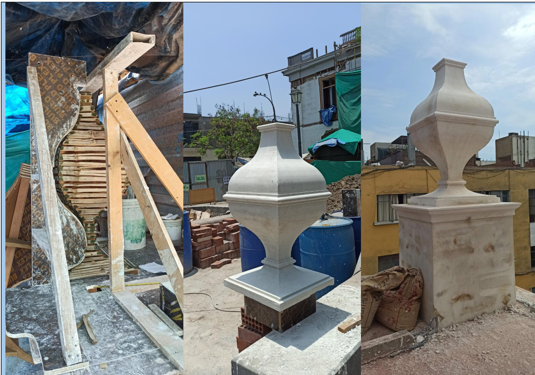
3.1. Fases del monitoreo: Proceso constructivo de ánfora de quinchá revestida con trabadillo.
