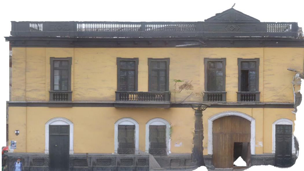
Fig. 07: Ortofoto de la fachada frontal del hospital, con frente a la Plazuela de la Buena Muerte.
