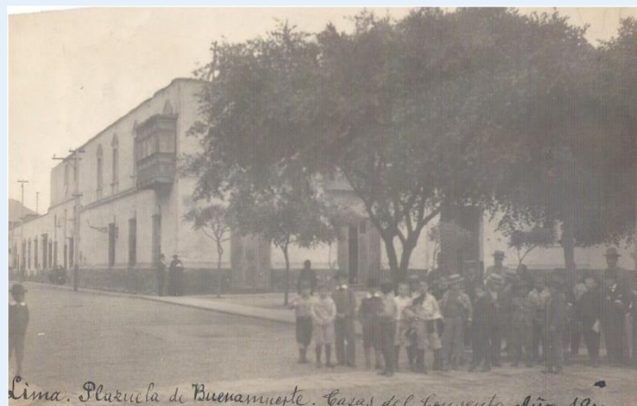
1.1. Fotografía de 1900. Se observa la configuración de las ventanas del primer nivel hacia Paruro con Conopeo. Las ventanas del segundo nivel con el antepecho de yeso y la altura del zócalo. El cual corresponde a la altura actual que se mantiene en ese frente. También se observa el balcón de cajón en esa fachada. Fuente: Archivo Conjunto de Nuestra Señora de la Buena Muerte.
