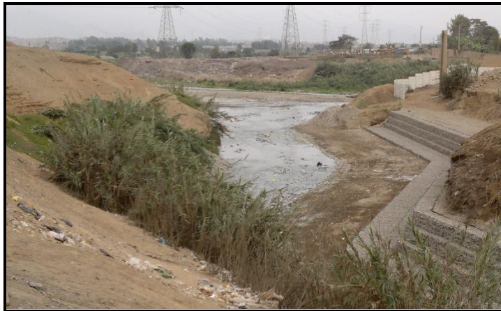
Figura 93: ESTADO ACTUAL RÍO CHILLÓN
