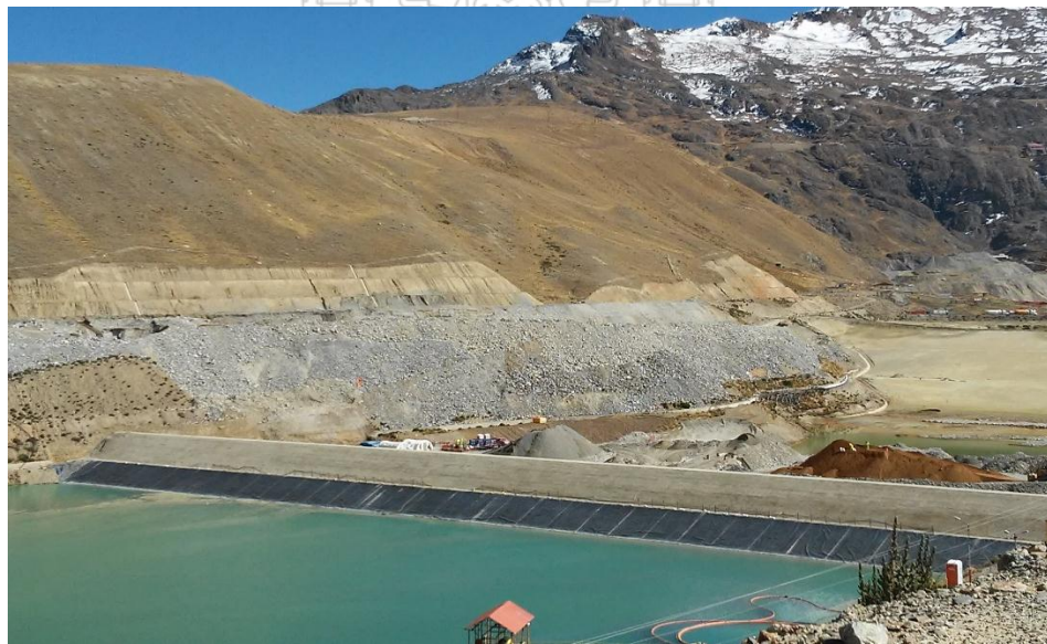
Fotografía N° 9: Deposito de Desmorte Cancha B 2.5
