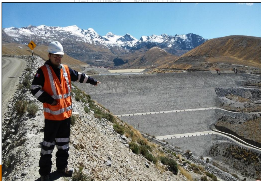
Fotografía N° 10: Deposito de Desmorte Dique BIII
