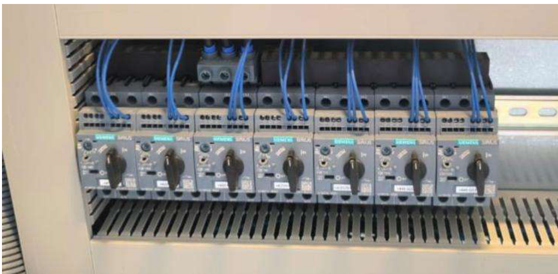
Sistema Modular de Protección SIRIOUS de Siemens para conmutación y protección de equipos
