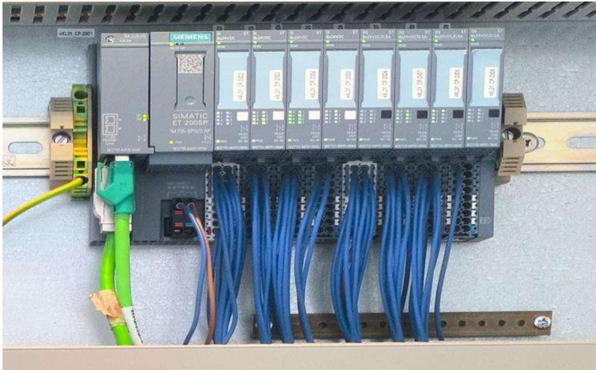
Módulo de Comunicación SIMATIC ET200SP de SIEMENS, un sistema de periferia escalable modular, para la recopilación de señales
