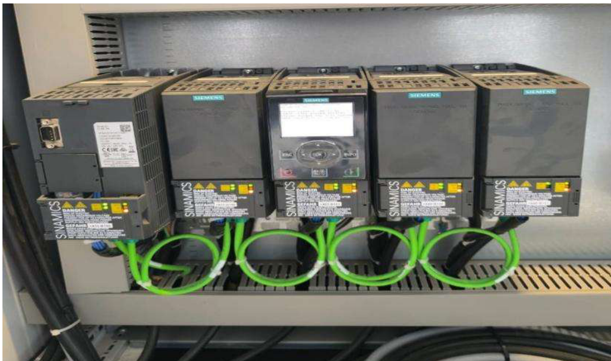
Variador de Velocidad G120X para motores trifásicos de Rastras Transportadoras
