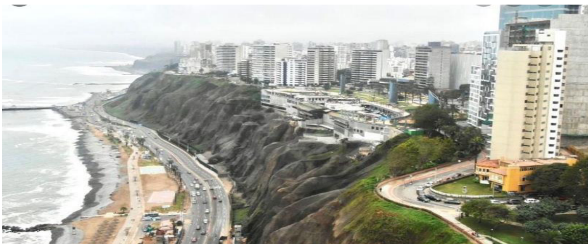
FOTO No 3 (Mirando al Norte). Al centro de la foto, el CC Larco Mar. En el acantilado se pueden apreciar las denominadas cárcavas , o entradas en formas de “cuchara”: indicativos de antiguos derrumbes de suelos. Nótese, además la línea de costa y el ancho del terreno ganado al mar y por donde está la autopista “La Costanera”.
