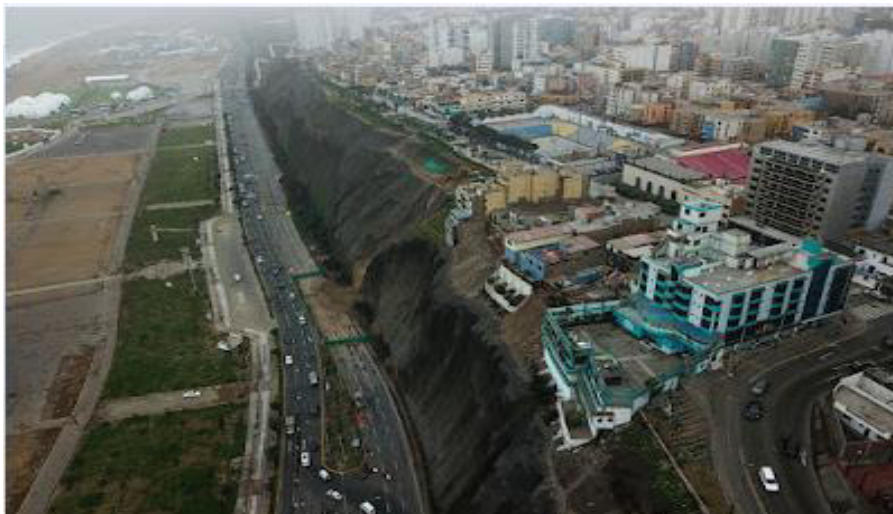
FOTO No 1 (Mirando al Norte). Derrumbe de suelos sueltos en Magdalena. Nótese el gran volumen de material acumulado al pie del acantilado e interrumpiendo el tránsito vehicular. Véase también la distancia a la línea de costa y la gran área ganada al mar.
