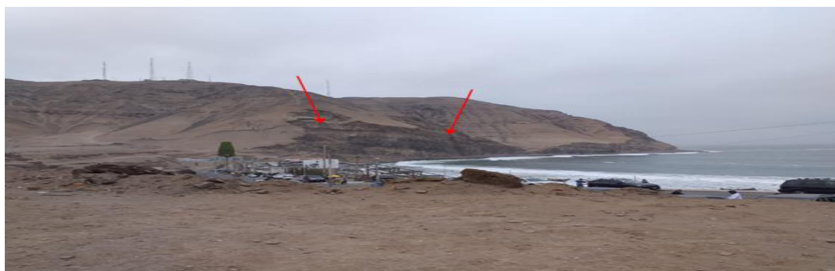
Foto No 15 (Mirando al Sur). Acantilado del cerro Marcavilca. Al pie de talud, por la orilla, se ubica la trocha (antigua carretera) a la playa La Chira. Nótese en la base del acantilado, la acción erosiva del mar y los estratos de areniscas del miembro Marcavilca, buzando hacia el oeste. Las flechas señalan los sectores con caídas de rocas permanentes; en el lado izquierdo se aprecian quebradas cubiertas por arena eólica.
