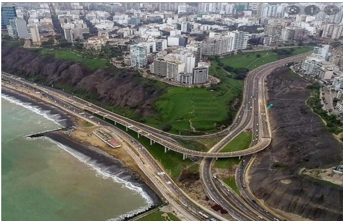
FOTO No 4 (Mirando al NE). Límite de Miraflores con Barranco en la Quebrada de Armendáriz, que es un antiguo cauce por donde desembocaba un ramal del río Rímac. Véase la franja de terreno ganado al mar, por donde está la autopista “La Costanera”
