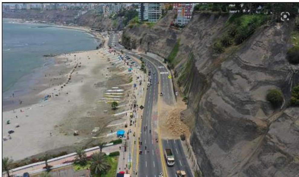
Foto No 5 (Mirando al Norte). Derrumbe de suelos sueltos; nótese el gran volumen desplazado al pie del acantilado y que ha interrumpido el tránsito en la autopista “La Costanera”. Véanse las cárcavas y también el área ganada al mar.
