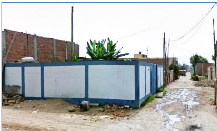
Foto N°08: Pozo de Extracción de Agua SEDAPAL
