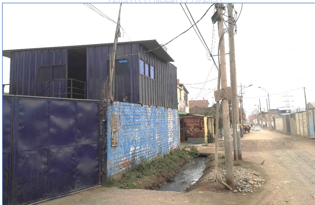
Fuente: Propia. En la foto observamos que las aguas servidas se conducen por canales que no se encuentran cubiertos, generando un foco de contaminación.
