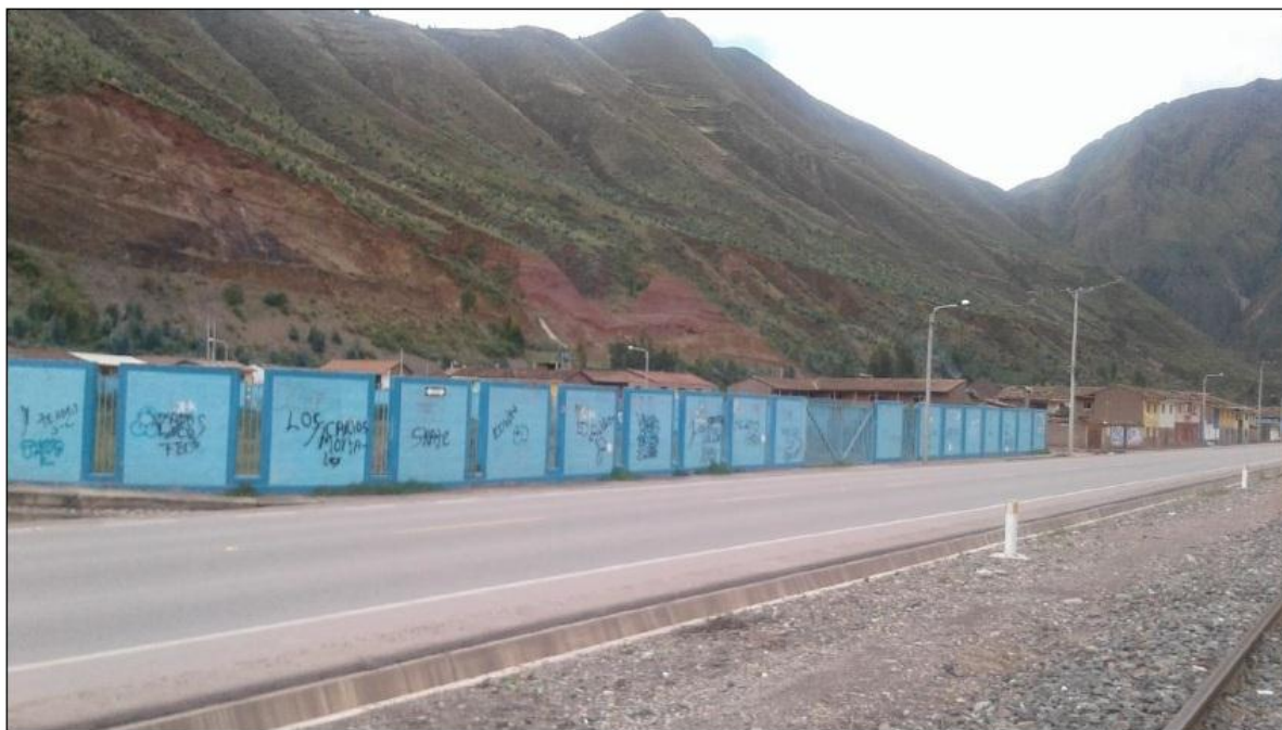
Figura 41. Vista fotográfica desde la carretera Cusco – Puno (Av. Perú) Fuente: Elaboracion propia, fotografia tomada in situ.
