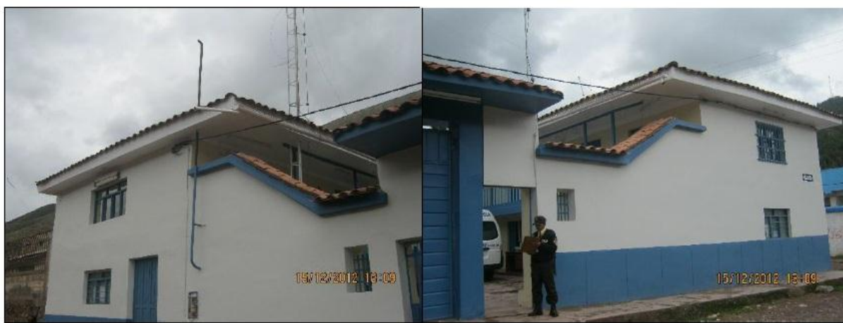
Figura 2: Fotografías del exterior Centro Medico de Urcos - Essalud Fuente: Propia, fotografía tomada in situ.
