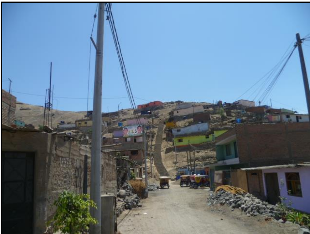
Fotos 16: Zonal 05- vivienda construida en terrenos con alta pendiente y sobre pircas de rocas y con escaleras como vía de acceso.
