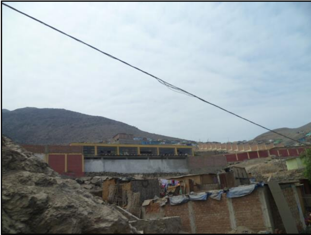
Fotos 11: Zonal 04- colegio y viviendas edificadas sobre pircas
