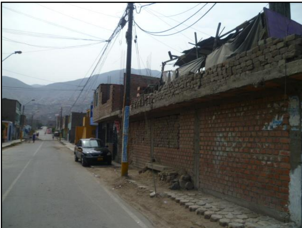
Fotos 10: Zonal 04- adobes apilados al borde del techo de una vivienda.
