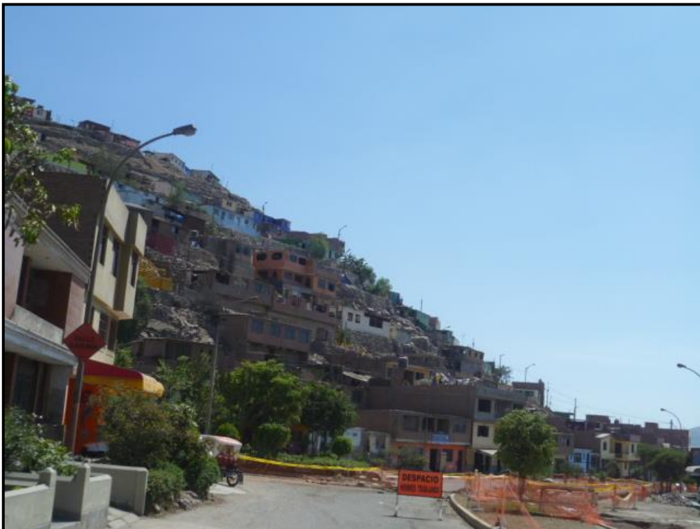
Fotos 14: Zonal 05- viviendas construidas en terrenos con alta pendiente y sobre pircas de rocas.
