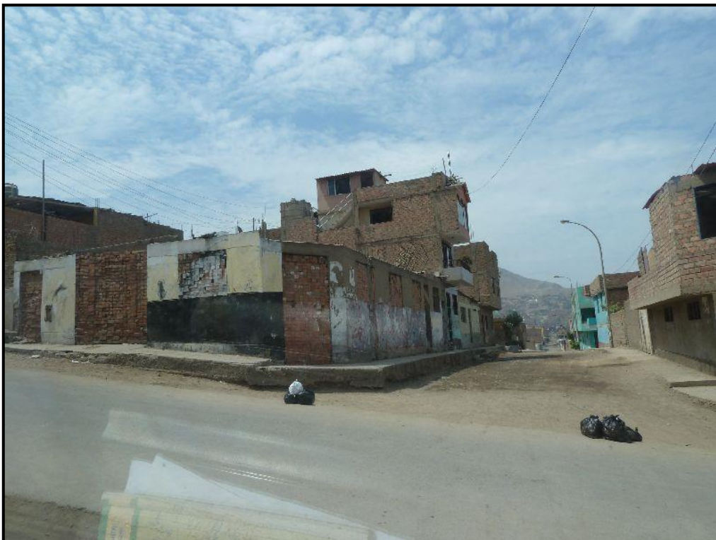
Fotos 8: Zonal 03- viviendas de ladrillos de dos pisos que afectaría a las viviendas de derecha e izquierda
