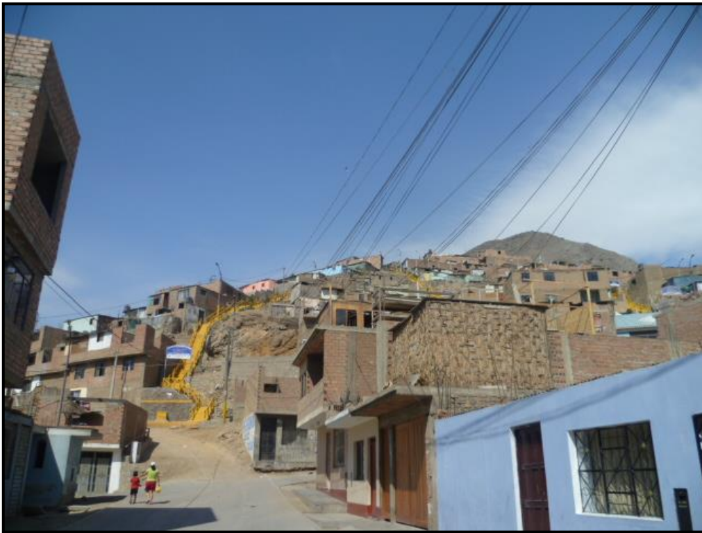
Fotos 17: Zonal 05- vivienda de varios pisos de ladrillos construidos en terrenos con alta pendiente, sobre pircas de rocas y con escaleras como vía de acceso.
