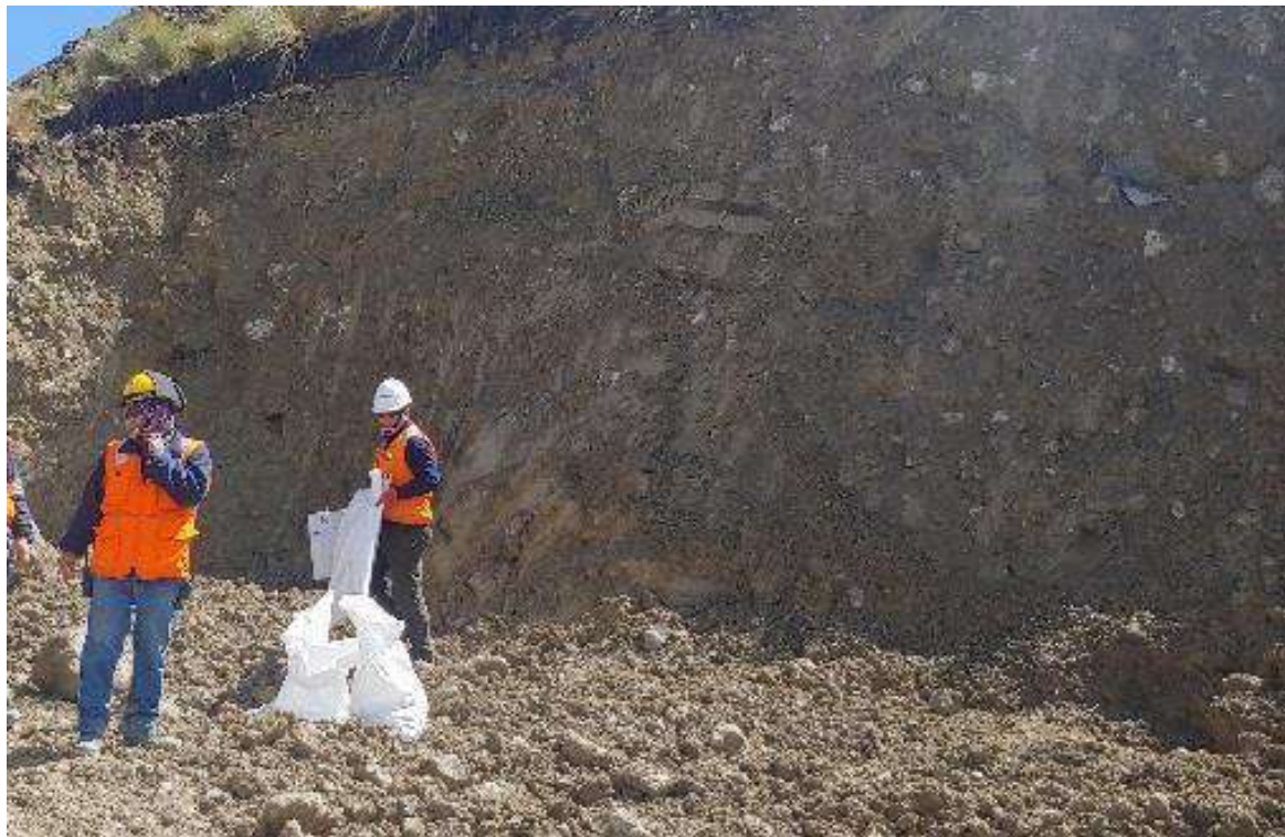
Imagen 12: Ensayo de densidad in situ Trinchera TR-SH-01
