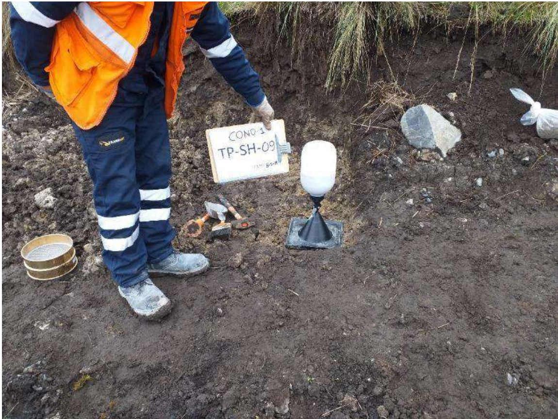
Imagen 11: Ensayo de densidad in situ Calicata TP-SH-09
