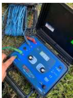
Medición final resistencia P-06 – Moyobamba
