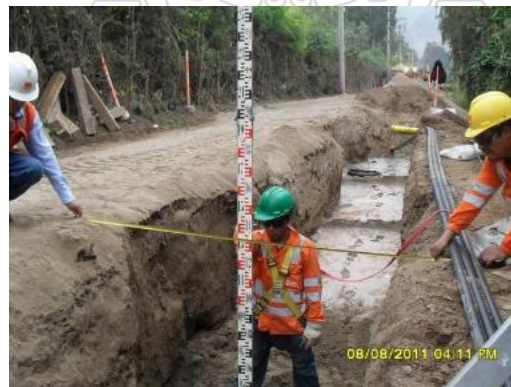
Vistas de supervisión de pruebas de hermeticidad y verificación de la profundidad de tapadas de tuberías de gas.
