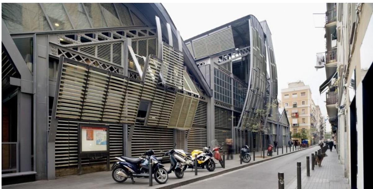
Fachada lateral del Mercado La Barceloneta
