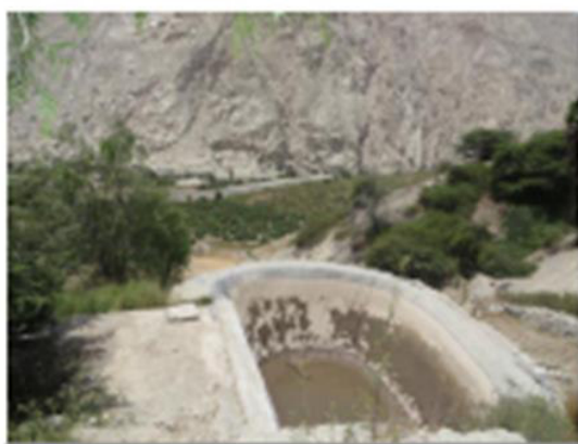
Reservorio principal hecho a base de Geomembrana
