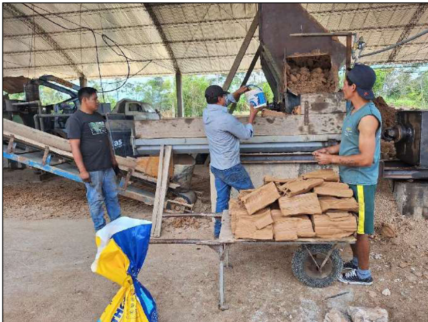
Imagen 06: Mezcla de material reciclado de construcción con la arcilla
