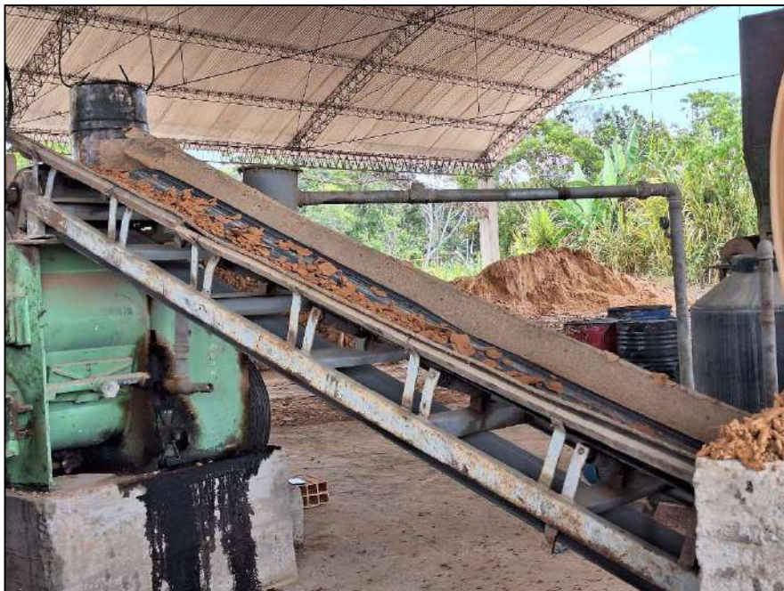
Imagen 08: Mezcla de material reciclado de construcción con la arcilla antes de entrar al molde
