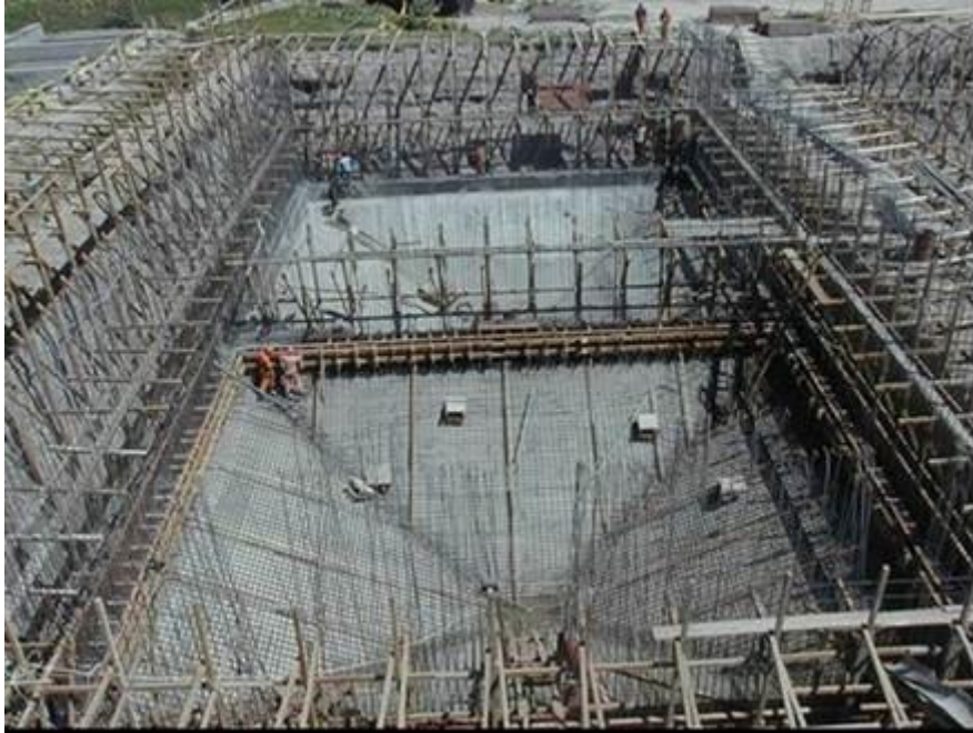
Fotografía 01 : Vaciado de concreto en la estructura inferior o cono de tanque
