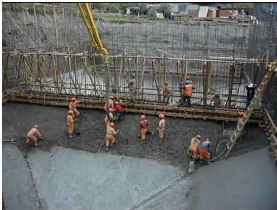
Fotografía 02 : Vaciado de la cámara de digestión del Tanque Imhoff 03
