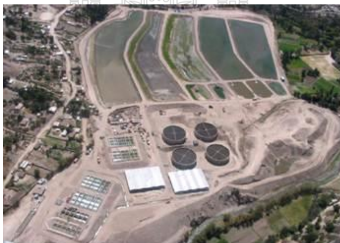
Figura 2.14 Vista panorámica de la PTAR de Totorá en Ayacucho (SEDA, 2016).
