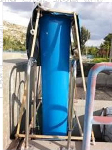
Figura 4.59 Manga flexible de polietileno cargado a su máxima capacidad con biogás.
