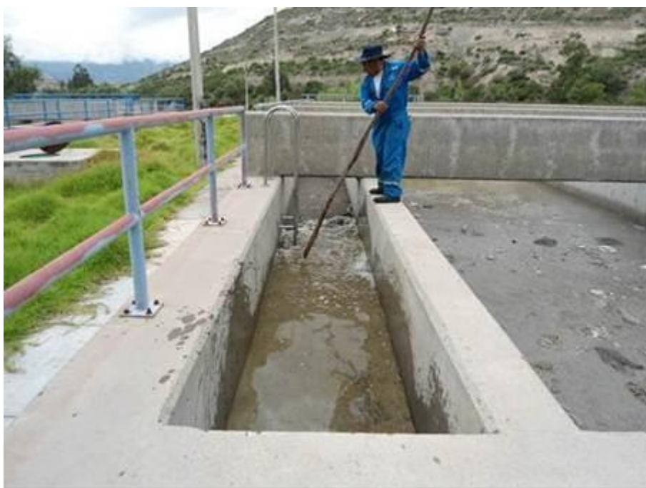
Figura 4.51 Limpieza del canal de ventilación izquierdo del tanque Imhoff 3, para proceder con las instalaciones de registro de biogás.
