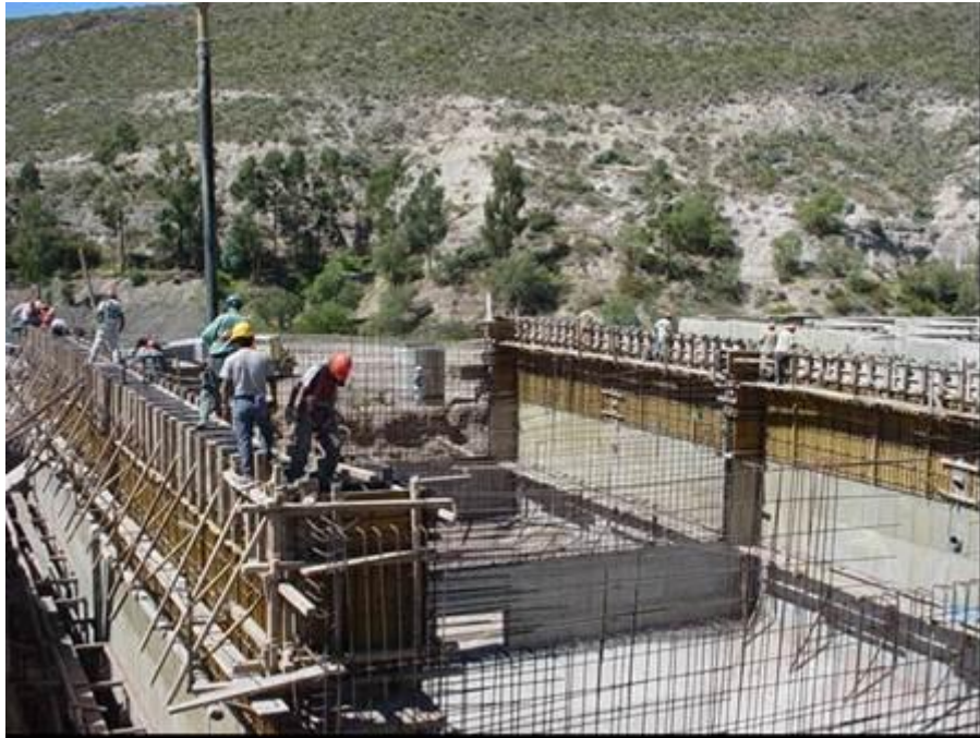
Fotografía 05 : Vaciado de los canales de venteo y último nivel
