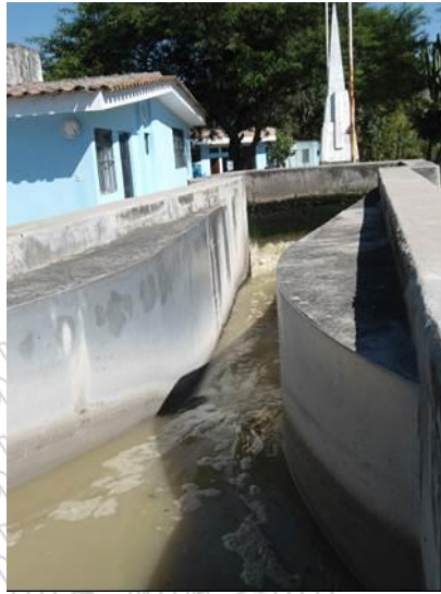
Figura 4.9 Canaleta de paso (Parshall) y carga de aguas servidas a la red de distribución subterránea.
