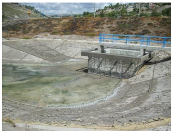
Figura 4.24 Drenado del líquido del sedimentador integrado para el secado de lodos y limpieza final.
