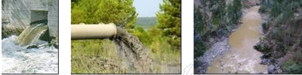
Figura 2.1 Vertidos directos de aguas residuales y contaminación de acuíferos.
