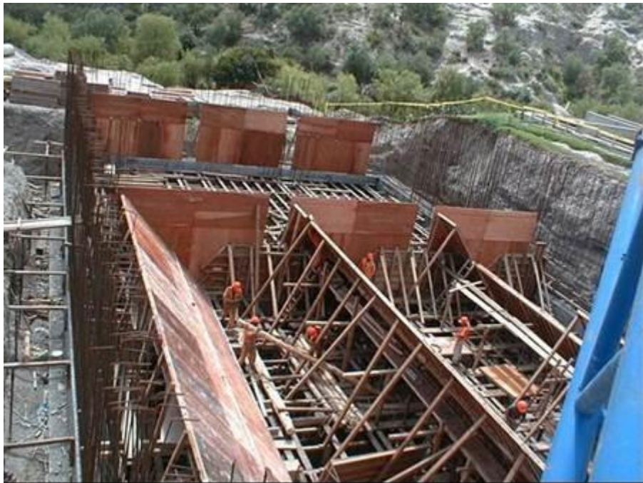
Fotografía 06 : Encofrado de las cámaras de sedimentación
