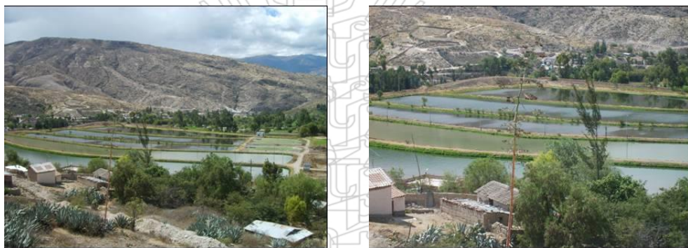
Figura 4.21 Lagunas facultativas 1 y 2 (las de adelante) seguidas por las lagunas de maduración y pulimento (al fondo).
