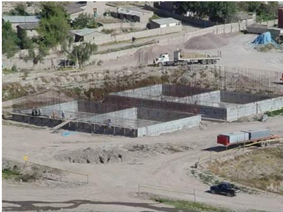
Fotografía 04 : Vista constructiva de los Tanques Imhoff 05 y 06
