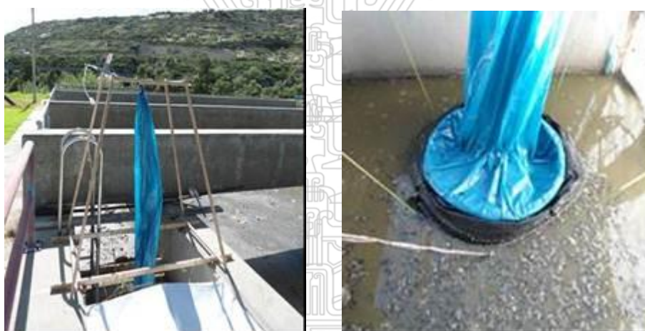
Figura 4.55 Instalación de la manga flexible para la colección del biogás, instalada sobre el líquido del canal de ventilación.
