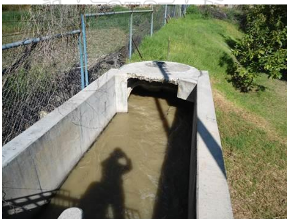
Figura 4.1 Cámara de recepción de aguas residuales que ingresa a la PTAR de Totorá.
