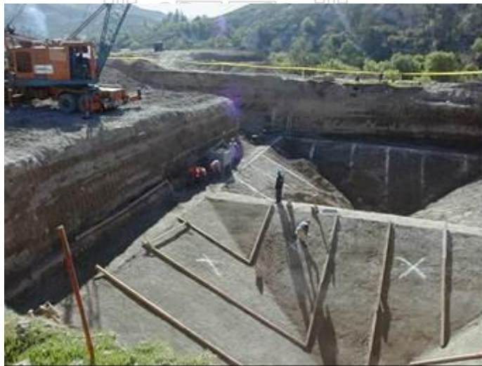
Figura 4.34 Remoción de tierras para la configuración del tanque Imhoff, con refinado de la pirámide inferior (cámara de digestión).
