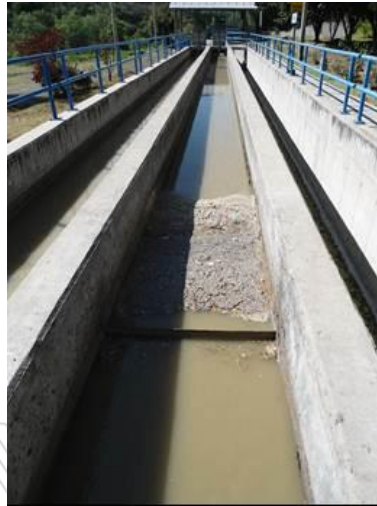
Figura 4.7 Bafle superficial para separación de aceites, grasas y ceras flotantes, instaladas al final del canal desarenador.
