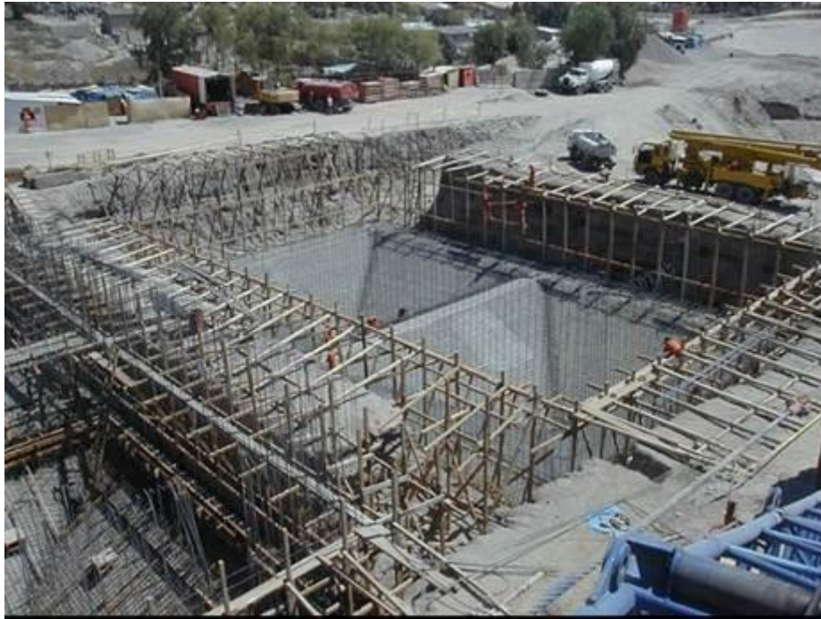
Fotografía 03 : Estructura del solado del Tanque Imhoff 04
