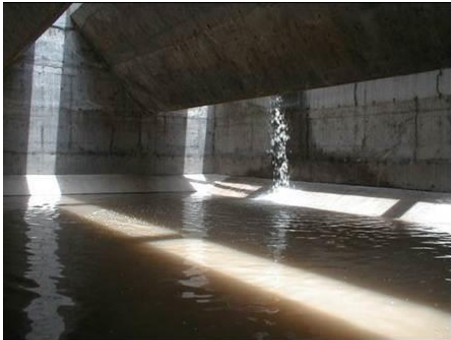
Fotografía 08 : Carga y prueba hidráulica del tanque Imhoff
