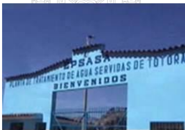
Figura 2.13 PTAR de Totora en Ayacucho ( SEDA, 2016 ).
