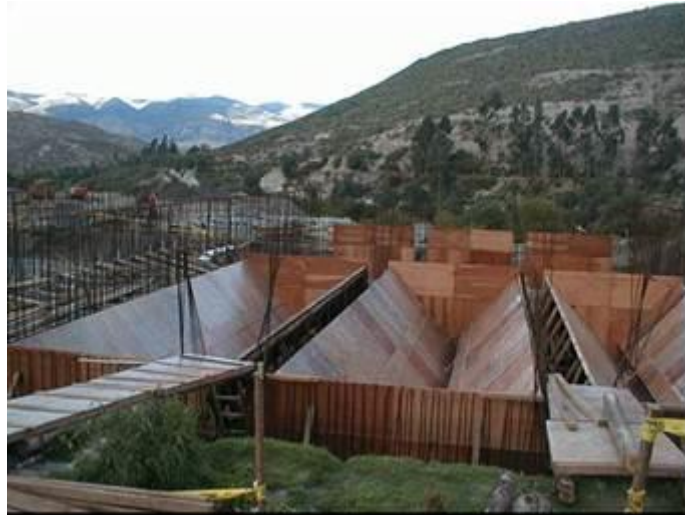
Figura 4.35 Encofrado de las cámaras de sedimentación con fondo tipo V abierta con traslape hacia el fondo.
