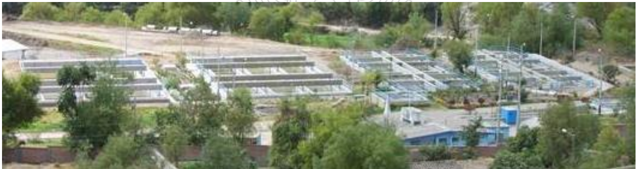
Figura 4.11 Vista panorámica de cuatro tanques Imhoff de la PTAR de Totorá (Imhoff 1, 2, 3 y 4, enumerados de derecha a izquierda).
