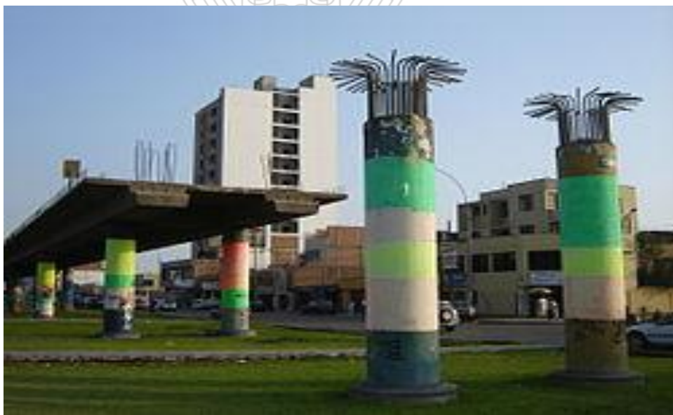
Figura 7: Tren eléctrico: viaducto inconcluso
