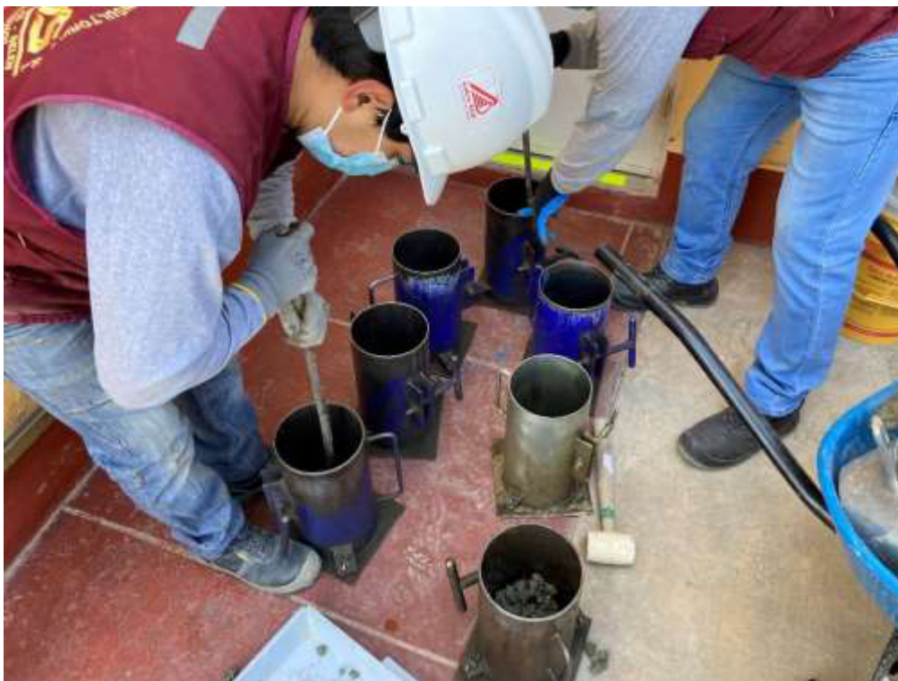
Vertido de concreto poroso en moldes metálicos para la elaboración de probetas.
