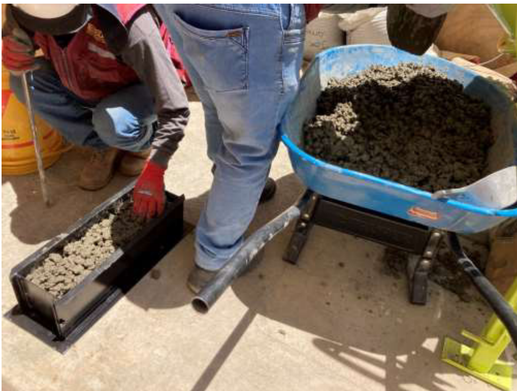
Vertido de concreto permeable en moldes para vigas.
