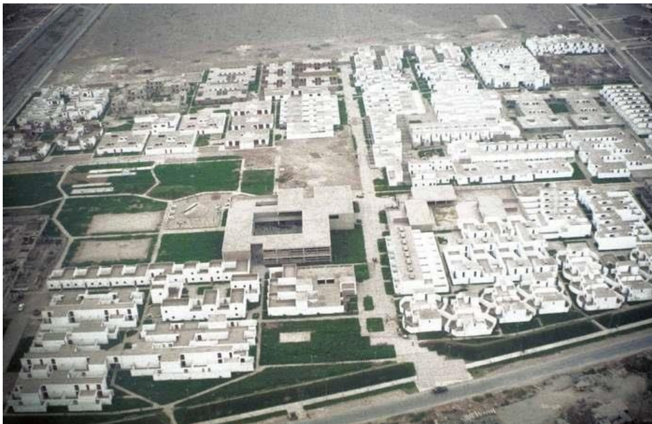
Ilustración 6. Previ desde Vista Aérea
