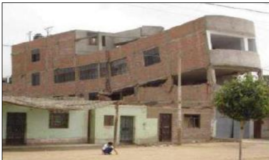
Grafico 5 Falla estructural por falta de líneas sucesivas y una mala configuración del sistema estructural. (Fuente: Córdova ingenieros.Sac)
