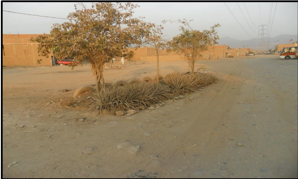
Figura N° 8: Ausencia y carencia de asfaltado- Colindante a Avenida de Canta Callao
