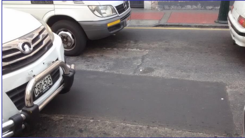
Parches y cortes utilitarios, sobre otro preexistente
