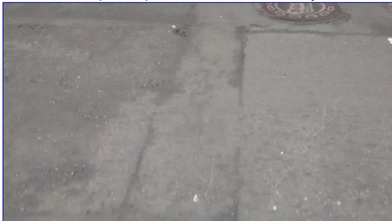
Canalización saliente de cámara de redes
