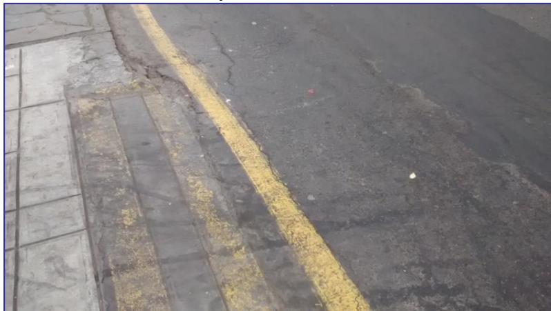
Rampa vehicular invadiendo la vía y reduciendo el ancho de los carriles
