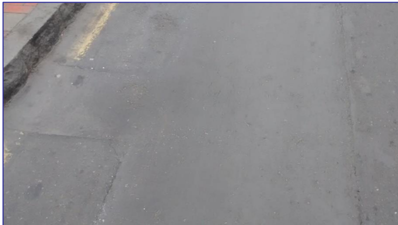
Parche de canalización y derivación a predio
