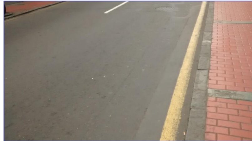
Canalizaciones vecinas de servicios dispuestas longitudinalmente
