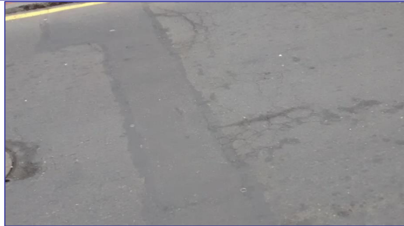
Parchado de canalización sobre zona de falla en pavimento
