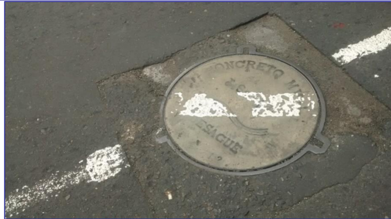
Bache en torno a tapa de buzón de desagüe
