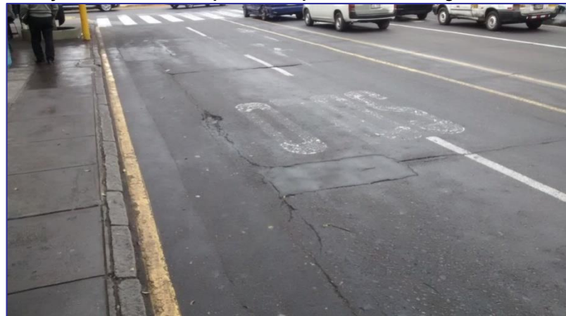
Parche utilitario en medio de fisura transversal y parche longitudinal
