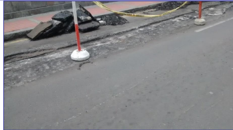
Pavimento retirado y colocación de elementos de seguridad
