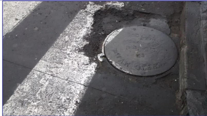
Baches y corte en torno a tapa de Sedapal, nótese la antigüedad de la tapa
