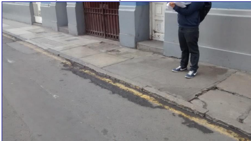
Canalización en paralelo a vereda para conexiones domiciliarias nuevas
