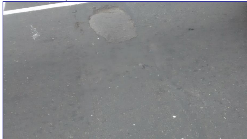
Parche de concreto sobre canalización resanada de asfalto
