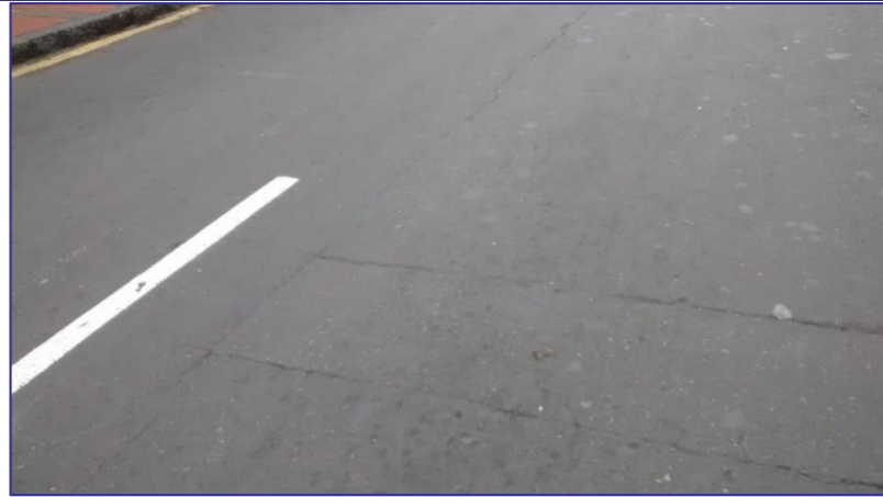
Corte en vía converge a canalización central para instalación de servicios
