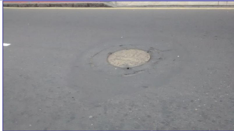
Fallas en torno a buzón resonado de Sedapal
