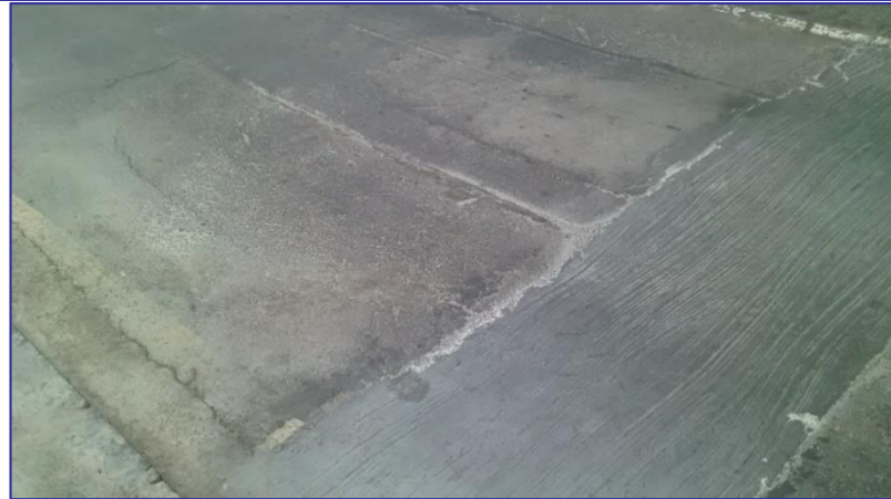
Vía de pavimento flexible con parche utilitario de concreto
