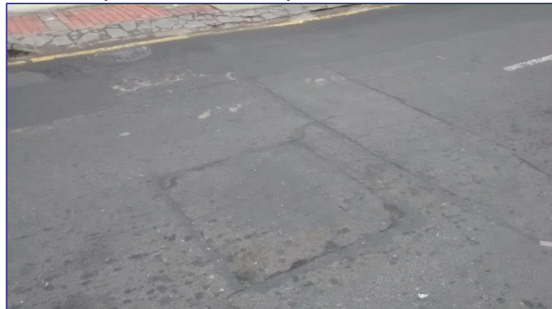
Parchado de canalización convergiendo en cámara de telefonía
