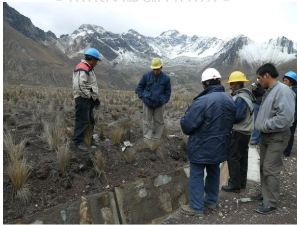
Verificando la construcción de los canales de coronación
