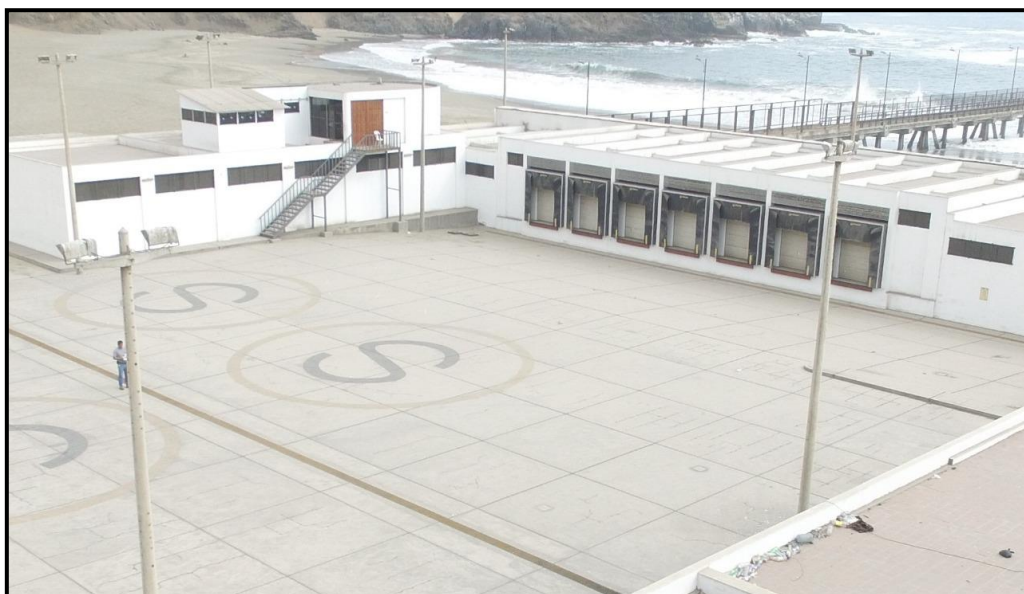
Patio de maniobras y área administrativa
