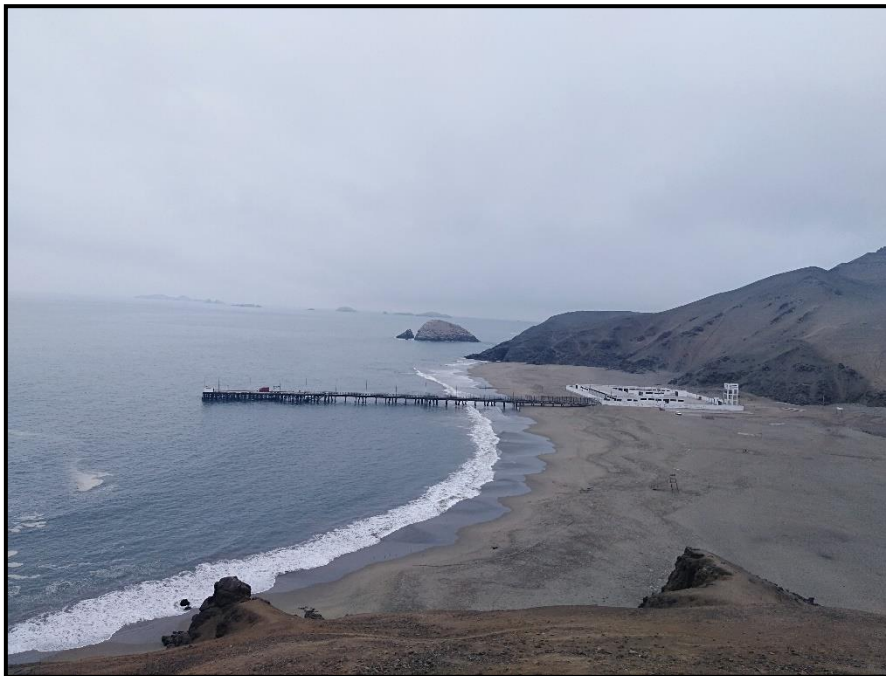
Vista panorámica de las obras en mar y tierra del DPA Bahía Blanca
