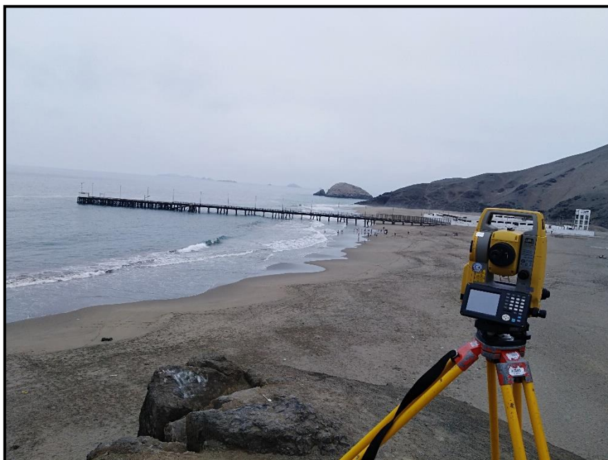
Trabajos en Área Ribereña
