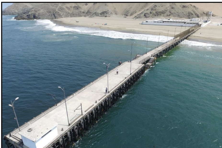
Vista superior del muelle espigón - Imagen con DRON
