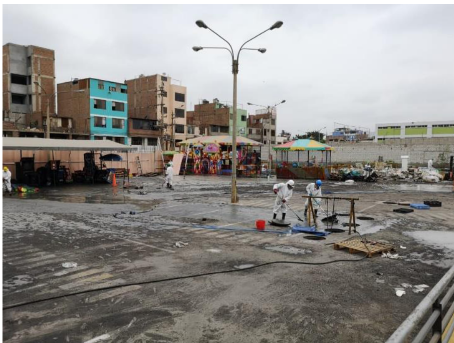
Figura 6 Estacionamientos y patio de maniobras
