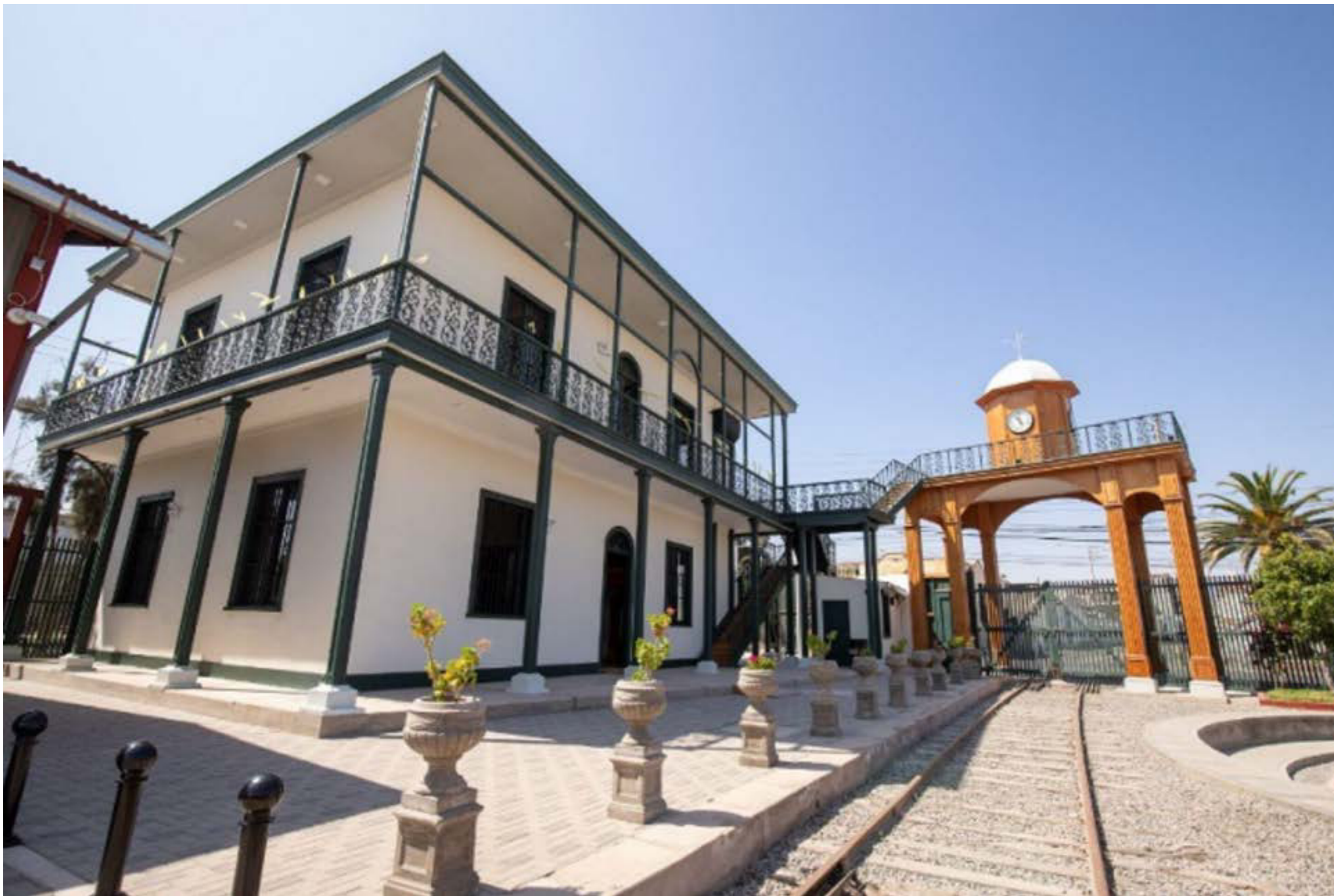
Figura 31 Estado Actual 2023 - Edificio de Servicios Turísticos
