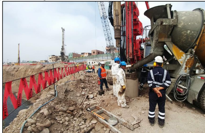
Figura 57: Fotografía del concretado de pilote mediante tubería tremie
