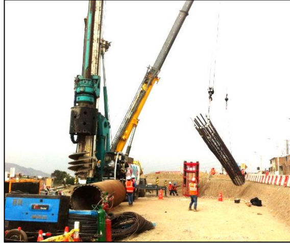
Figura 56: Fotografía de maniobras mediante grúa para el colocado de la armadura del pilote Estabilizador vial 1 – Proyecto Línea Amarilla
