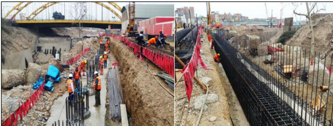
Figura 59: Fotografías de la construcción de la viga de encepado de la pantalla de pilotes Construcción de una pantalla de pilotes – Proyecto Línea Amarilla.
