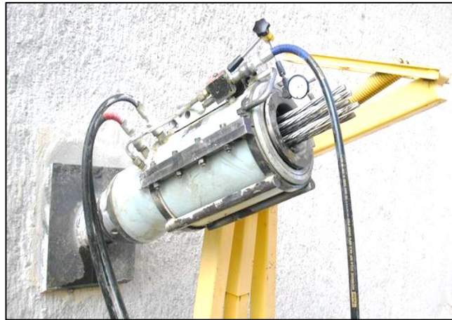
Figura 44: Tensado del anclaje
