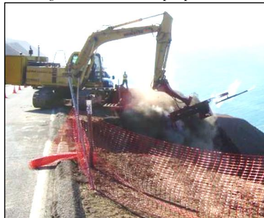
Figura 41: Perforación por percusión
