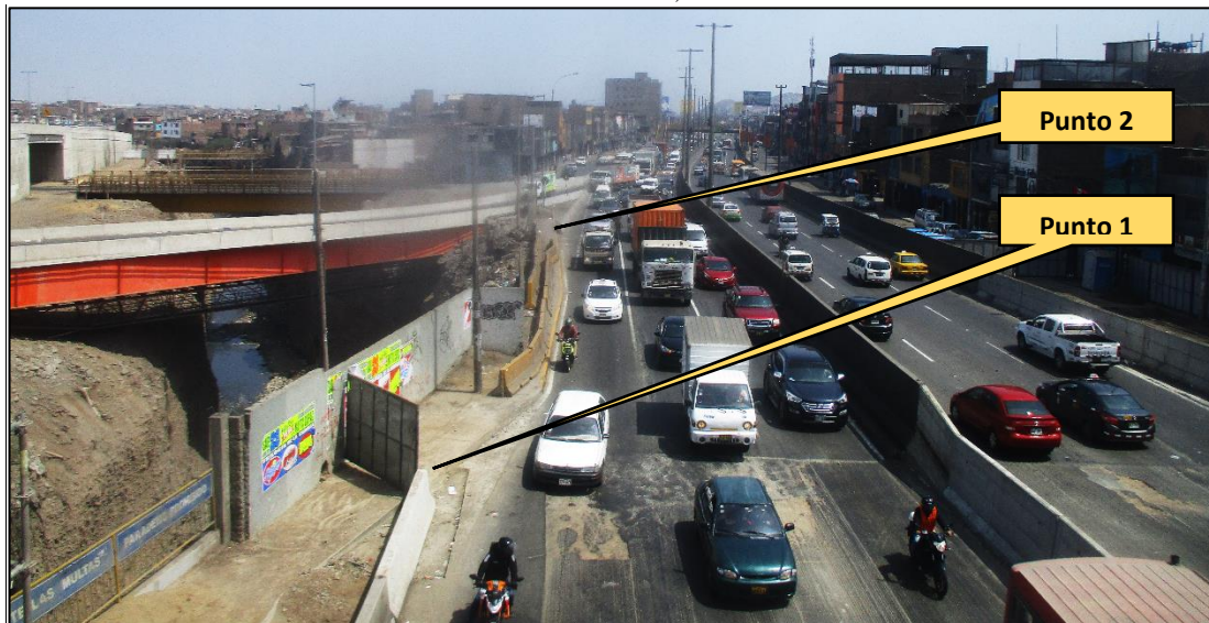
Fotografía 3 Socavación al pie del talud vertical en la zona de estudio.
