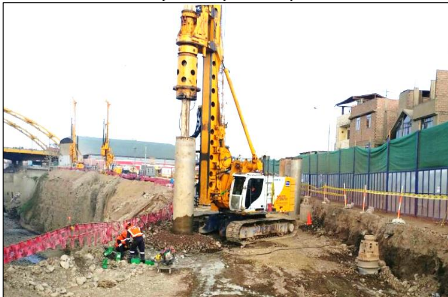
Figura 52: Fotografía de la perforación de pilote mediante camisas Construcción de una pantalla de pilotes – Proyecto Línea Amarilla.
