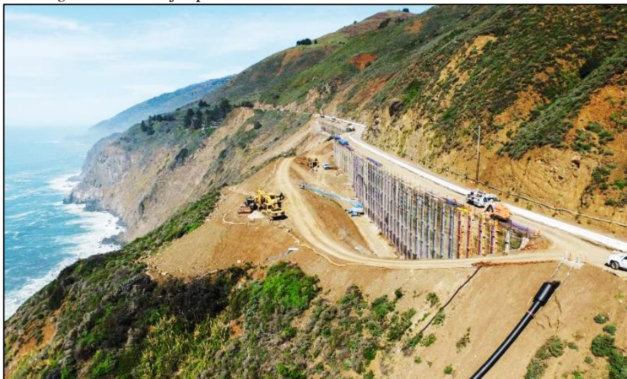
Figura 36: Anclajes permanentes en la estabilización de un talud inestable
