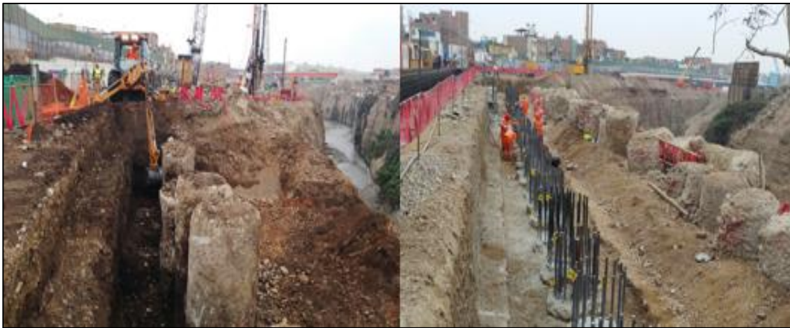
Figura 58: Fotografías de la excavación y retiro del concreto excedente de pilotes Construcción de una pantalla de pilotes – Proyecto Línea Amarilla.
