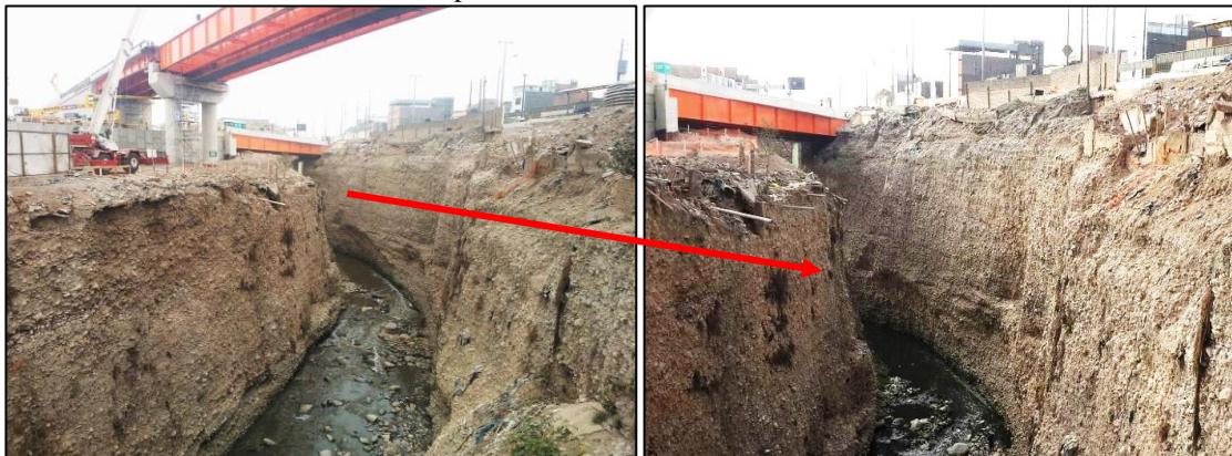
Fotografía 3 Socavación al pie del talud vertical en la zona de estudio.
