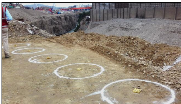
Figura 51: Fotografía del trazo de pilotes discontinuo sobre el terreno Construcción de una pantalla de pilotes – Proyecto Línea Amarilla.
