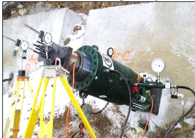
Figura 45: Prueba de carga en anclaje
