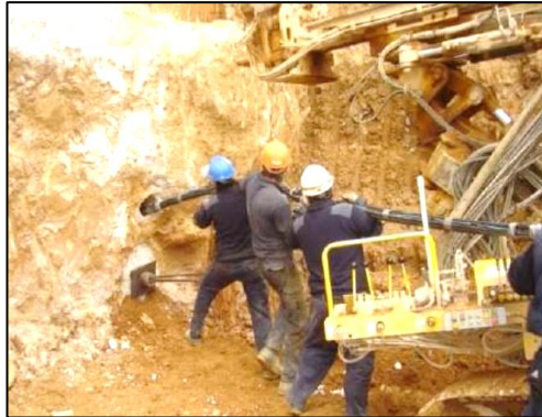
Figura 42: Instalación de tirantes
