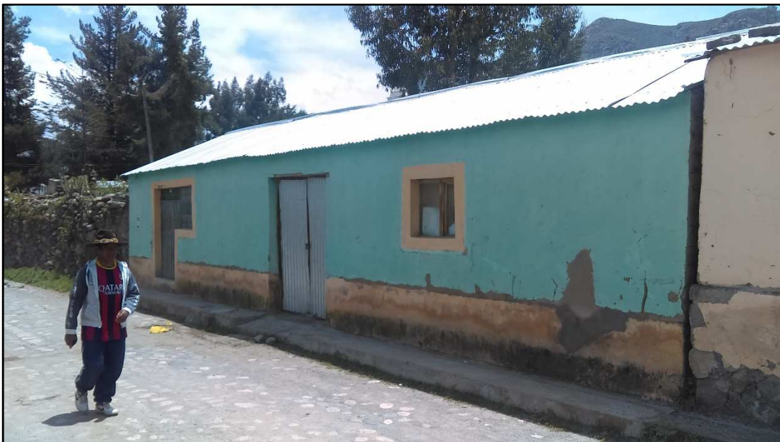
Fotografía Nro. 11 Vivienda en estado Recuperable, Marzo 2017
