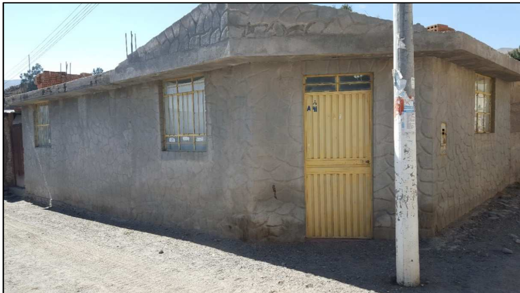
Fotografía Nro. 13 Vivienda sin Daño, Marzo 2017
