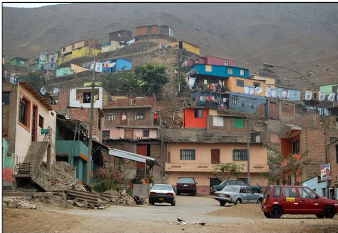
Fotografía Nro. 1 Edificaciones expuestas y susceptibles a un peligro de origen natural
