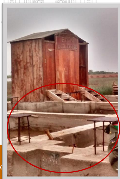
Fotografía N° 24: Cimientos de una construcción no terminada-baño ecologico
