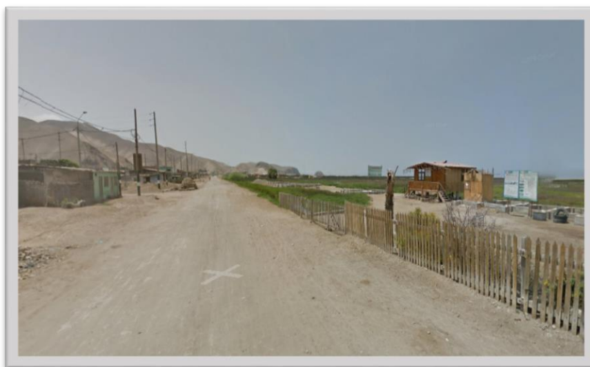
Fotografía N° 36: Vía que circunda el ACR sin asfalto
