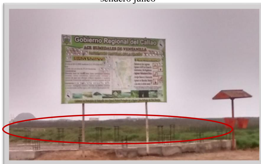
Fotografía N° 23: Cimientos de una construcción no terminada-ingreso sendero junco
