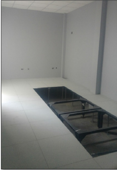
Foto de la sala Data Center con piso técnico
