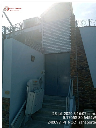
Foto del ingreso con salva escaleras
