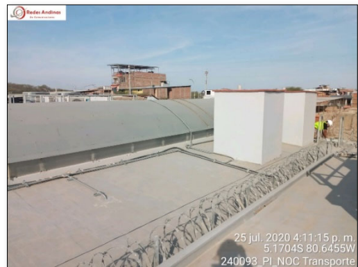
Vista de las teatinas y bóveda con policarbonato (pasadizo)
