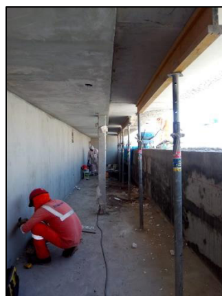
Acabados de fosas y caseta
