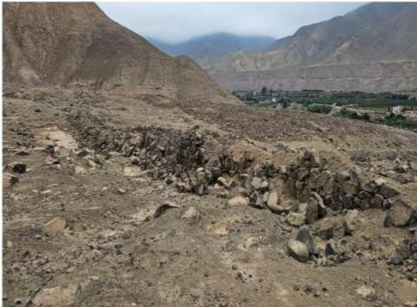
Foto Nº 3. Vista panorámica Noroeste. Se Puede apreciar el muro de contención de orientación Este-Oeste
