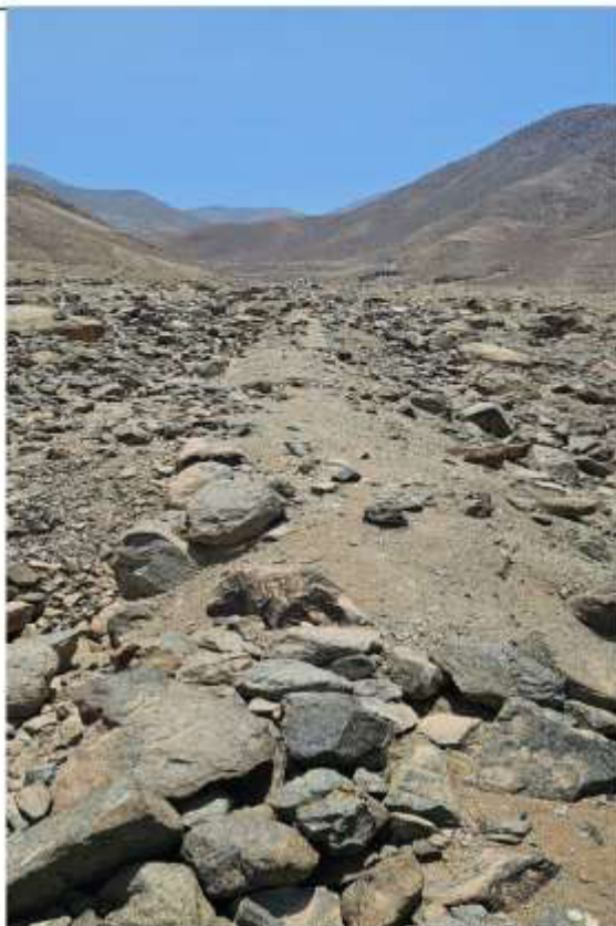
Foto N° 7. Detalle cabecera Muro de Contención, orientación Norte-Sur.
