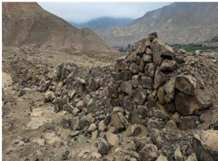
Foto Nº 4. Vista del Muro de contención, Detalle de la técnica constructiva de la arquitectura prehispánica
