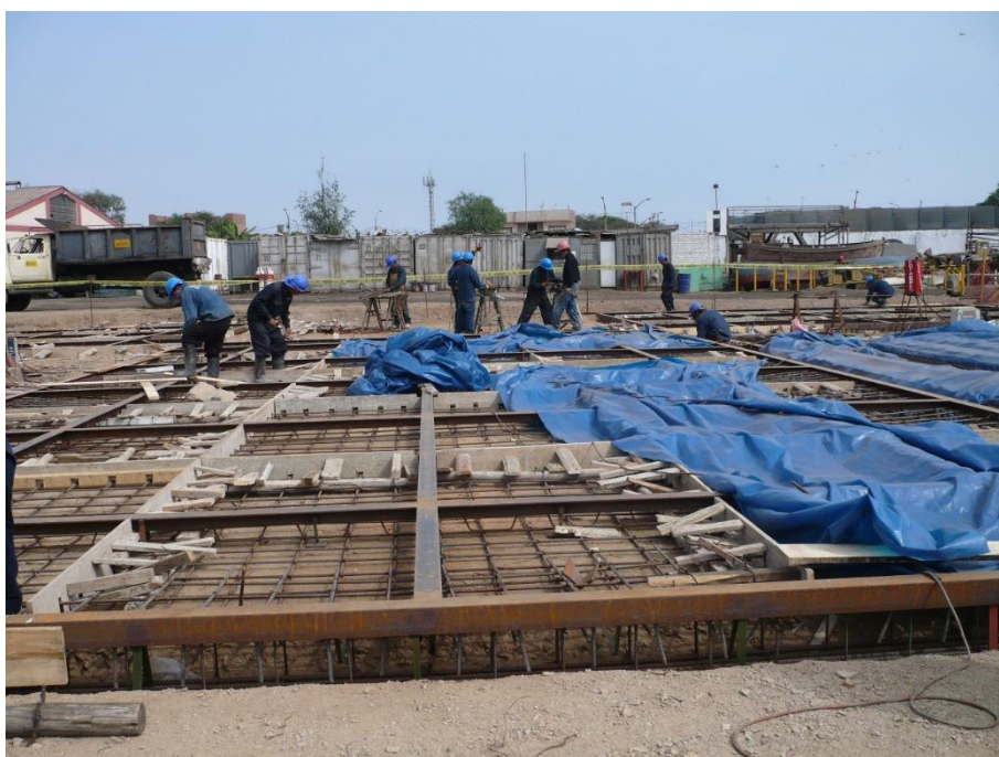
LOSA ARMADO EN ASTILLERO DEL SIMA
