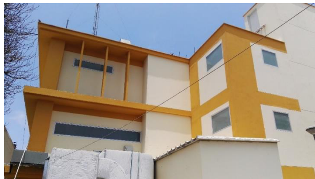
Vista del Cuarto Tecnico y Equipos de AA
