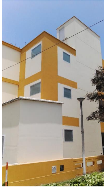
Vista del Cuarto Técnico
