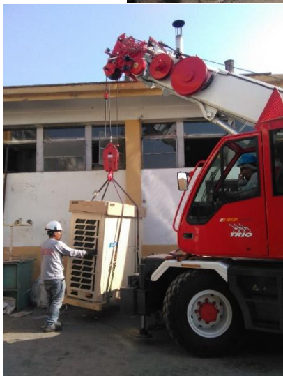
Maniobras de izaje de los equipos de Aire Acondicionado al Techo del Tercer Piso
