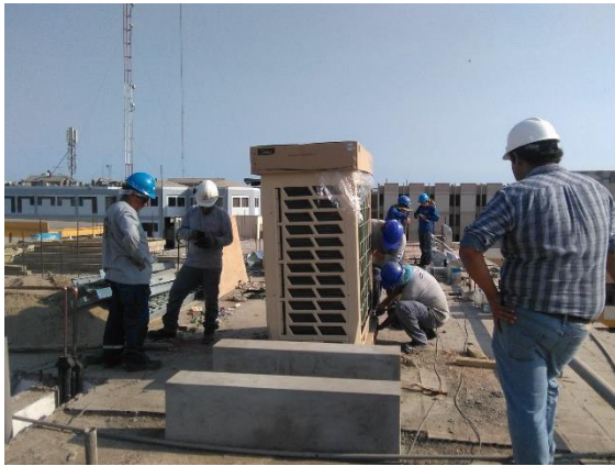
Maniobras de izaje de los equipos de Aire Acondicionado al Techo del Tercer Piso
