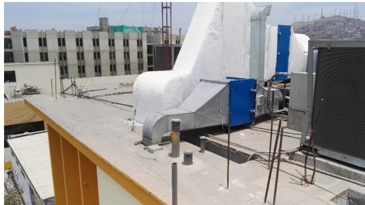
Acabado de instalación de ductos y equipos de Aire Acondicionado
