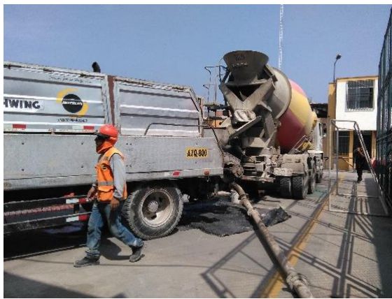
Vaciado de concreto de la cisterna de la UCI
