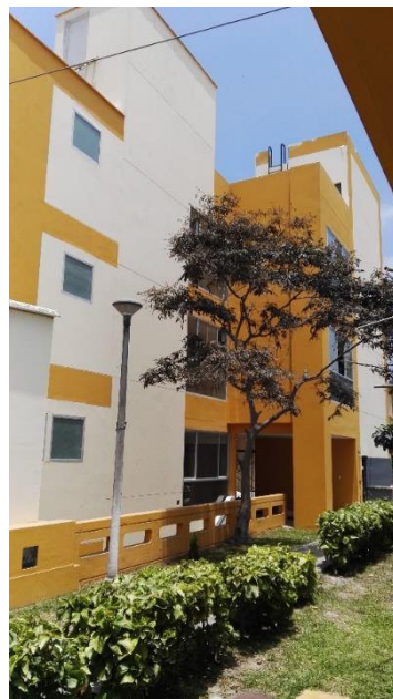
Vista Escalera de Emergencia
