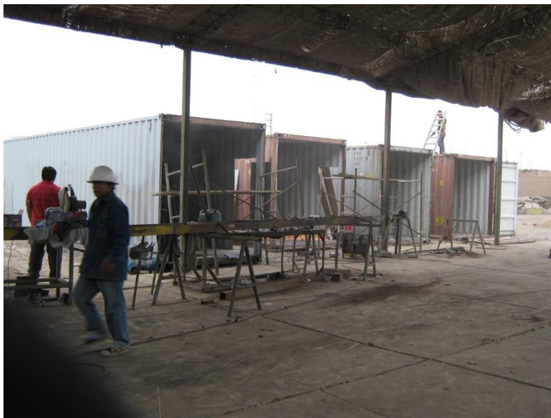
TALLER ACONDICIONAMIENTO DE CONTENEDORES EN EL TALLER HOSPITAL LOAYZA
