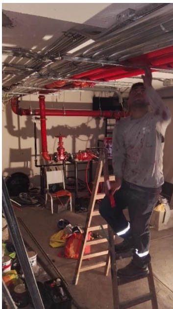
Instalación de los equipos en el Cuarto de Bombas de la Cisterna
