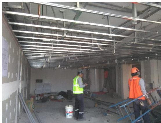
Acondicionamiento de cielo raso y tabiques de drywall
