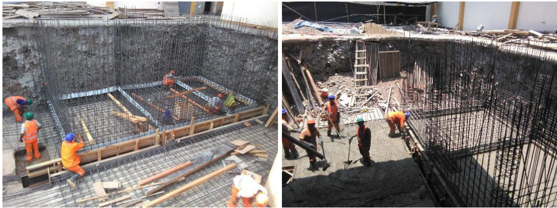
Supervisando la construcción de la cisterna de la UCI
