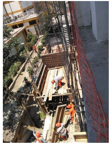
Encofrado de la Caja del Monta camilla y Escalera de Emergencia
