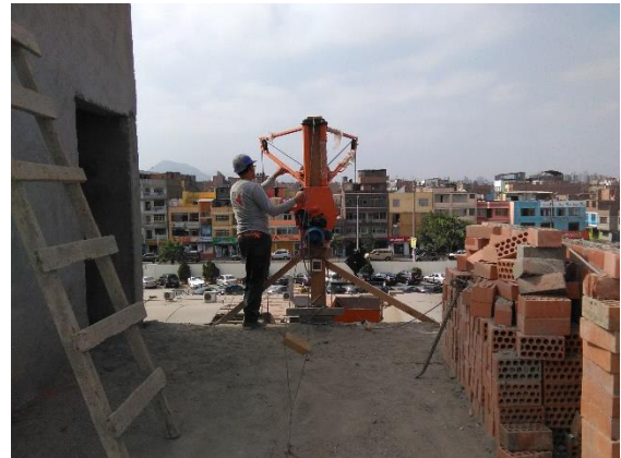
Subida de materiales a la azotea
