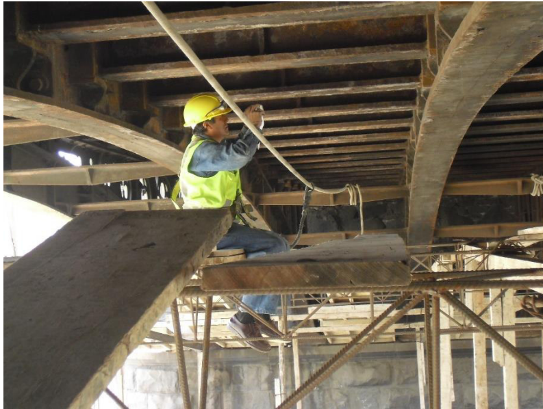
MANTENIMIENTO Y REFORZAMIENTO ESTRUCTURAS DEL PUENTE BALTA
