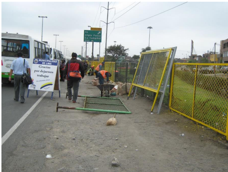
MANTENIMIENTO BARANDAS EMAPE
