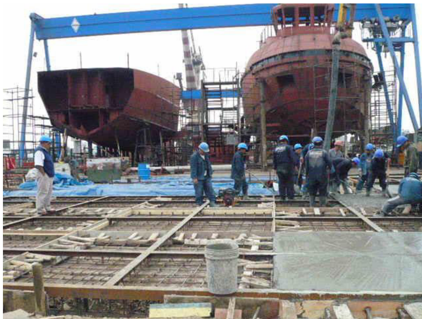
LOSA DE MONTAJE DE EMBARCACIONES SIMA
