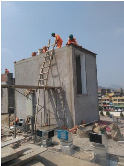
Terminando el cuarto de máquinas del Monta camillas
