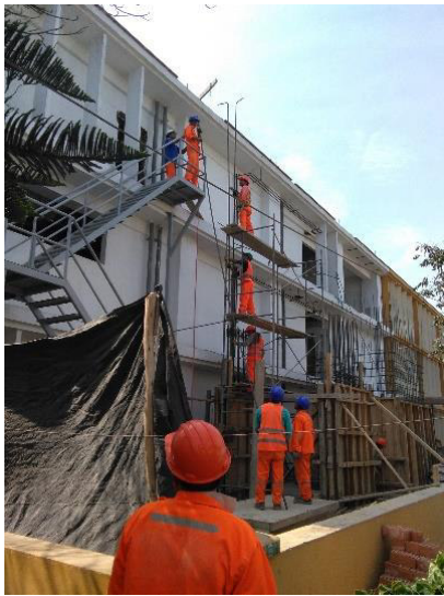
Encofrado de la Caja del Monta camilla y Escalera de Emergencia
