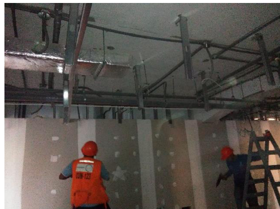
Acondicionamiento de cielo raso y tabiques de drywall
