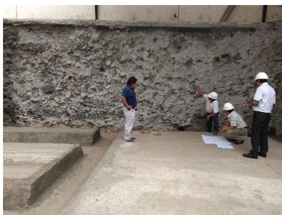
Supervisando la construcción de la cisterna de la UCI
