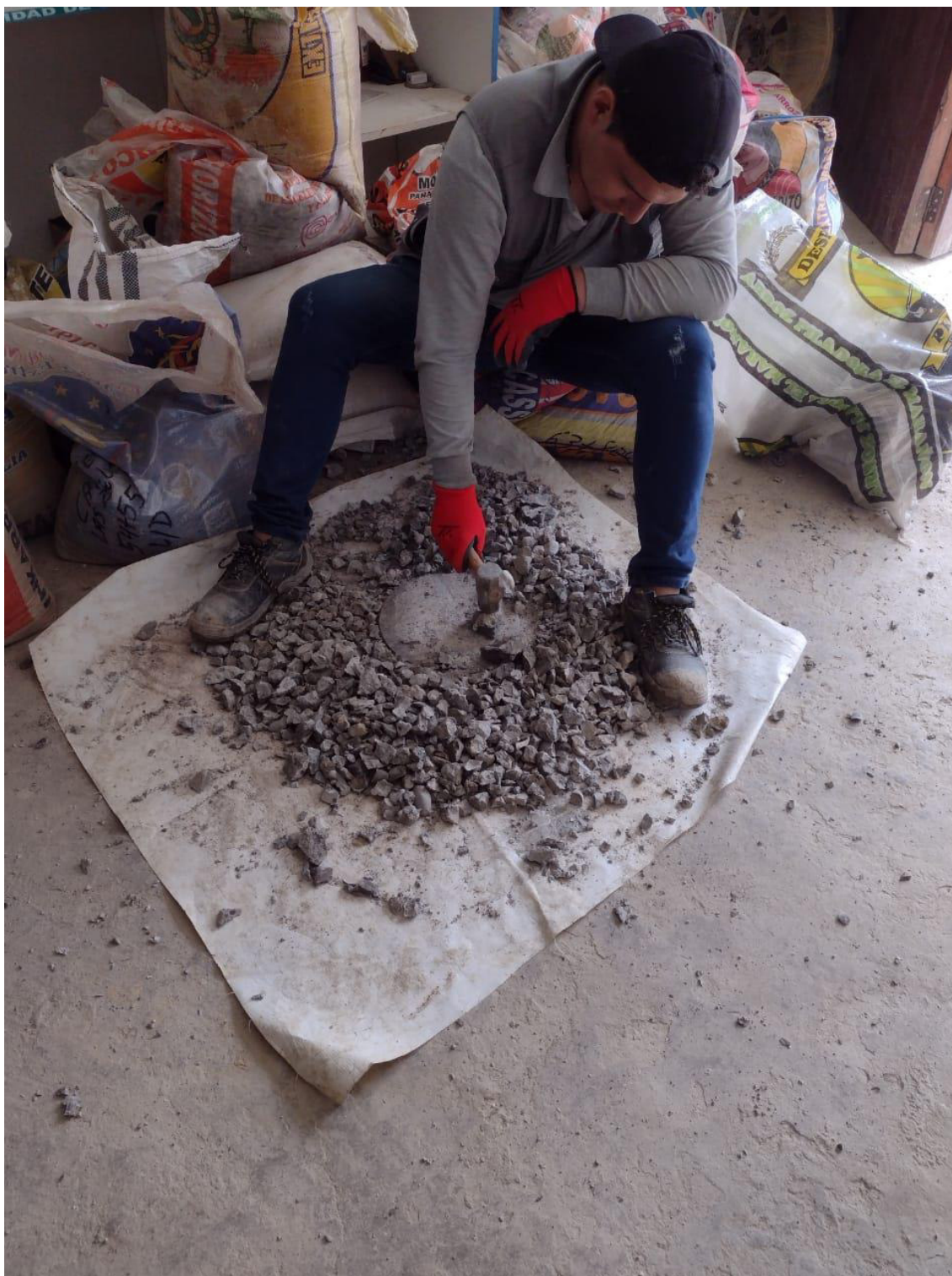
Fotografía 3. Trituración mecánica del concreto de demolición para producir agregados reciclados
